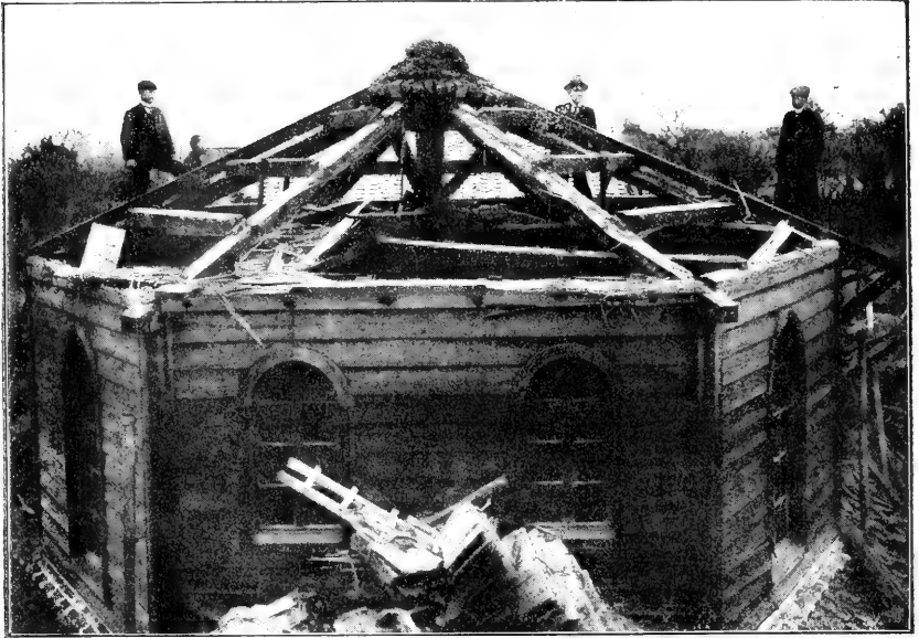
第六師團本熊衛戍監獄看守所小屋白蟻被害の状況
