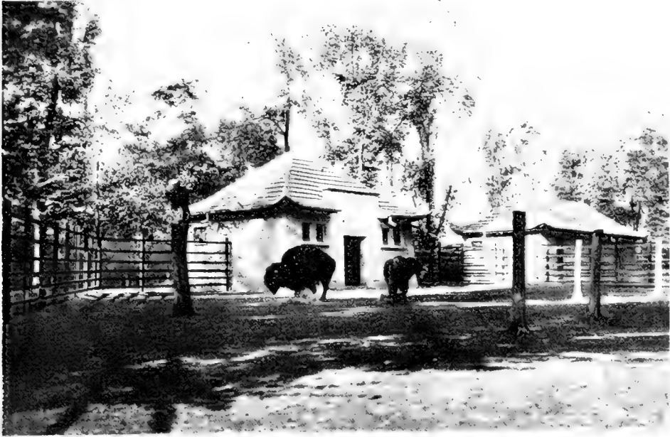
Fig. 25. — Gehege und Schutzhaus für Bisons. Errichtet 1926.
