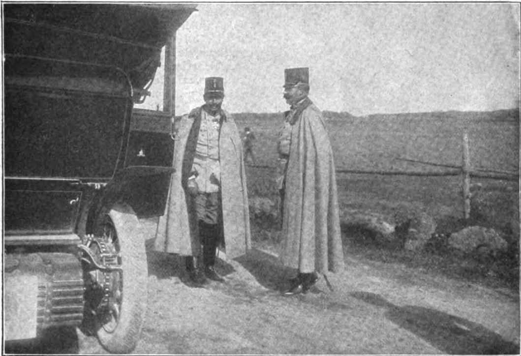
Kaiser Wilhelm II. und Erzherzog Franz Ferdinand im Manövergelände.
