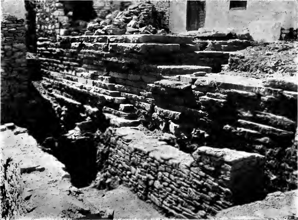
Abb. 2. Ansicht des Fundaments der nördlichen Mauer.
