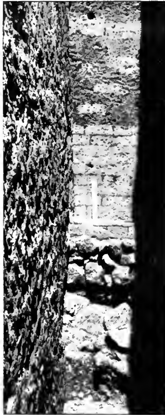
Abb. 2. Ziegelmauer der 2. Schicht mit Steinsöckel.
