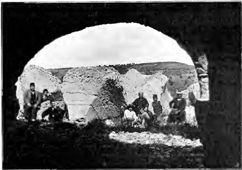
Fig. 10. Abgestürzter Zwickel der Cisterne auf Kösten
