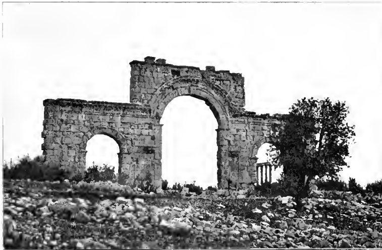
Fig. 23 Thoranlage in Uzundschaburdsch.
