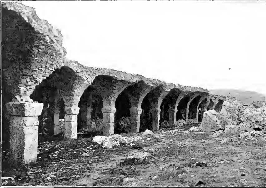
Fig. 8 Cisterne auf Kösten bei Smyrna.
