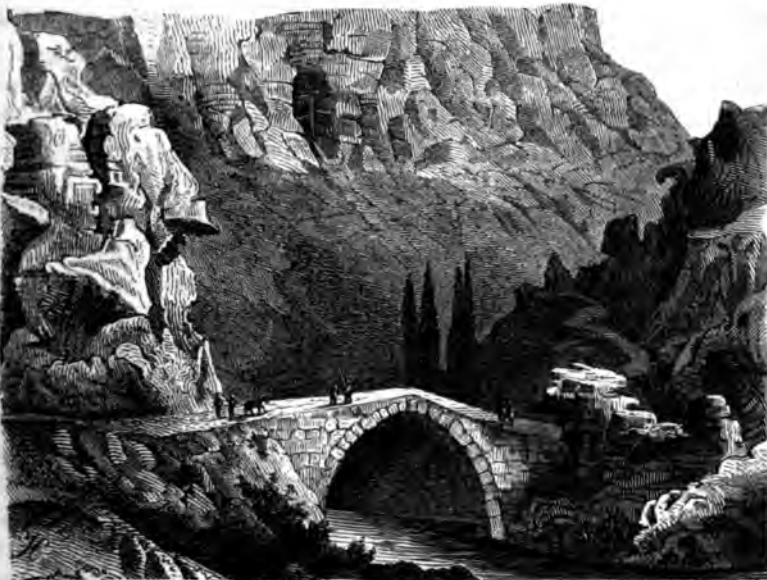
Engpass an der Römerbrücke bei Abila Lysanias.
