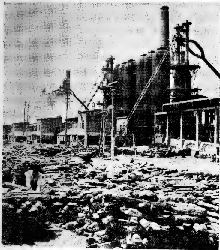
济南钢铁厂255立方米1号高爐
