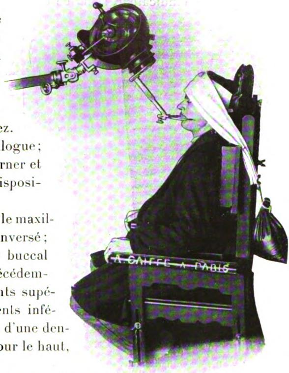
Fig. 15. — Projection horizontale. — Position pour la radiographie des incisives supérieures.
