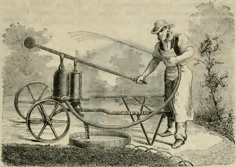
Fig. 4. — Pompe à double effet de M. Noël, à piston vertical.
