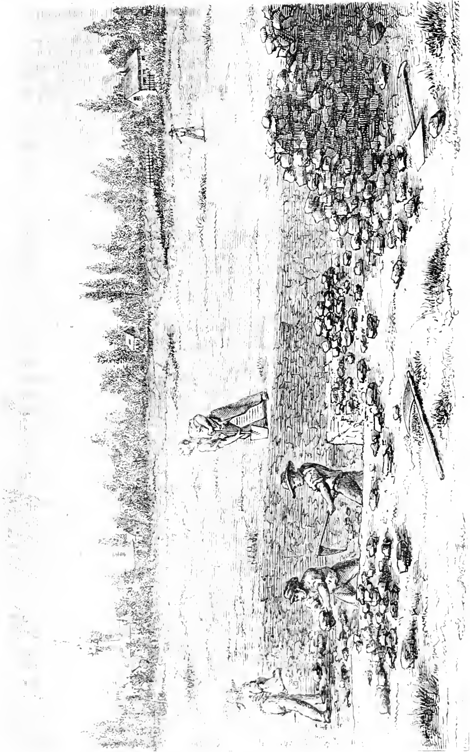
Fig. 26. — Vue d'une exploitation d'un rasement de tourbe pour l'emploi comme combustible ou engrais.
