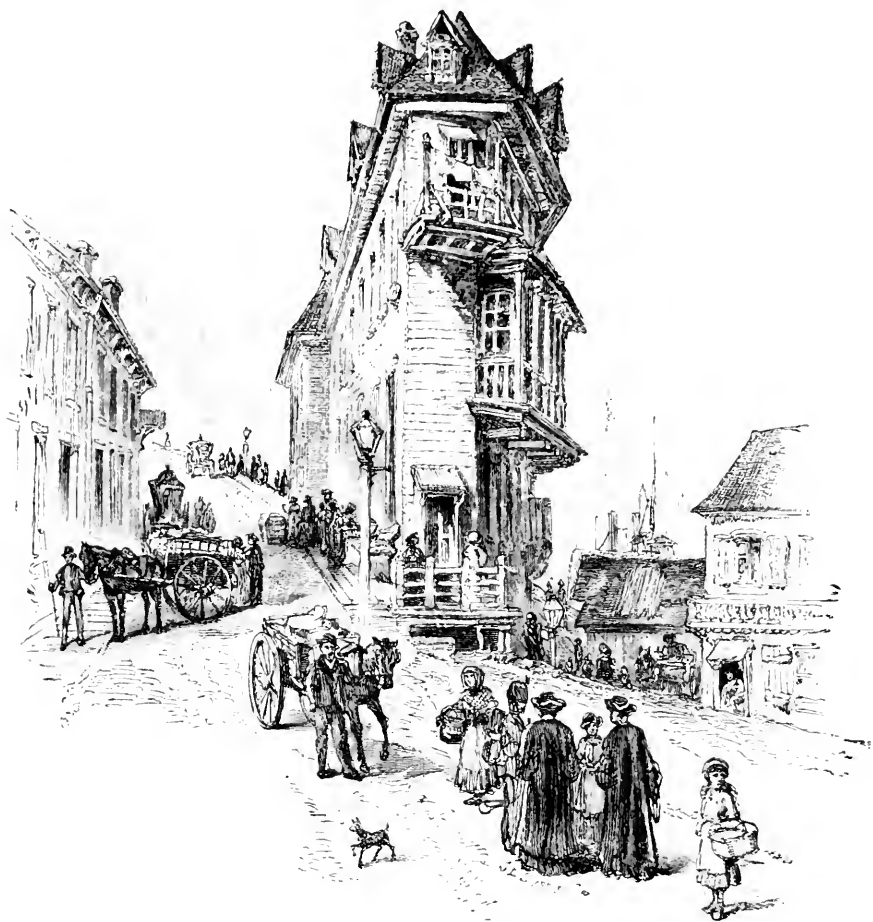
Fig. 8. Mtes Haus in Point Lévis.
