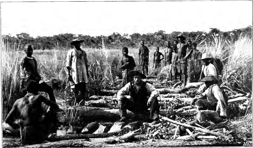
Abbildung 39. Brückenbau über den Maschonge.
