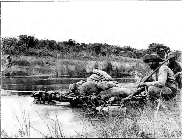
Abbildung 42. Uebersetzen über den Longa mittels eines aus Fässern hergestellten Flosses.
