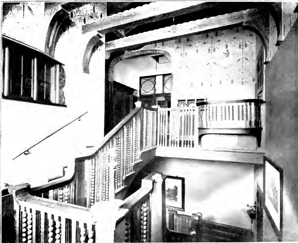
TREPPENHAUS IN DER VILLA HAUSSTEIN ENTWORFEN VON JOHANNES WILHELM
