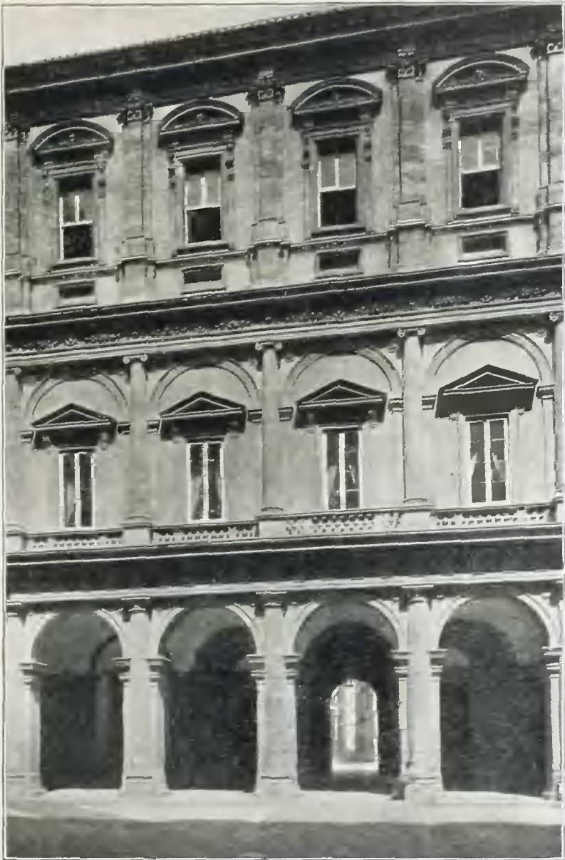
Abb. 228. Fassadenteil des Hofes des Palazzo Farnese in Rom.
