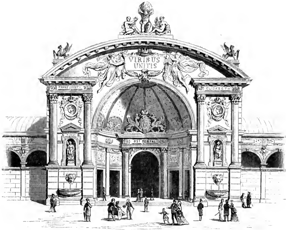
Ostportal der Industriehalle.
