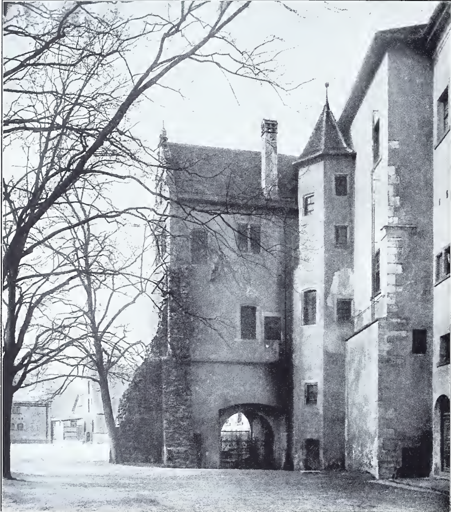
Abbild. 7. Der sog. Prinzessinnenbau der ehem. Karlsburg zu Durlach.
