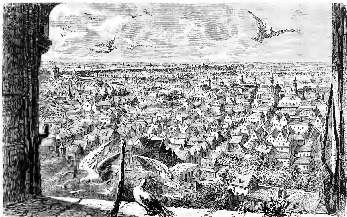
BRUGES, VU DE BEFFROI.
