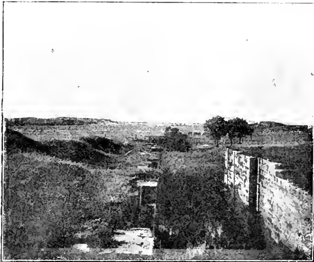
FIG. 4. — L'ancienne écluse de Fort-Mardyck.
