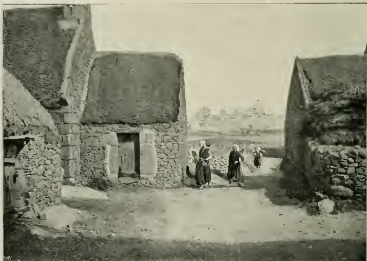
L E COMBLI de l'indigence semble réalisé dans ce hameau de linte. Seules les pierres angulaires ou servant de jambages sont taillées. Le dénuement de la campagne répond à celui de l'habitat. Pas d'arbres; de petits murs en pierres sèches encadrent quelques lopins cultivés. Les chaos de blocs empilés, au dernier plan, indiquent qu'on se trouve au sommet d'une bosse granitique, où la terre végétale est à peu près absente. Labor, d'agrie, comp. de l'Institut agronomique (Fig. 211).
