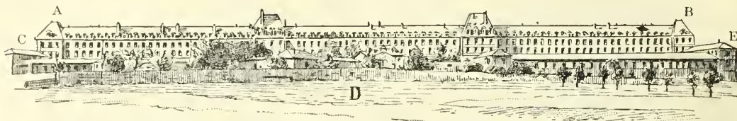
Fig. 1. — Façade nord du bâtiment principal de l'hospice de Bicêtre.
