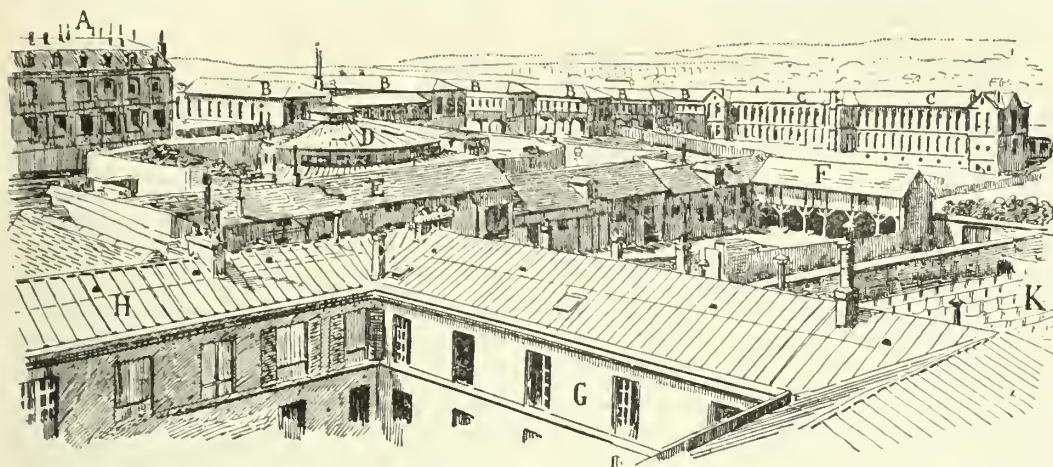
Fig. 2. — Vue d'une partie de Bicêtre prise du pavillon B (fig. 1). — A, ateliers des enfants; B, réfectoires; B, écoles; B,B,B,B, dortoirs; C,C, bâtiment des enfants gâteux; D, Sûreté; E, écuries et remises; F, Hangars et basse-cour; G, économat; H, cuisine; K, champ d'étendage.
