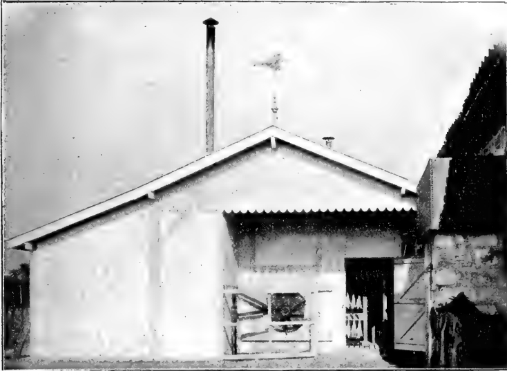
FIG. 46. — Sécherie de M. Mellis, à Bordeaux. Vue latérale montrant le ventilateur.
