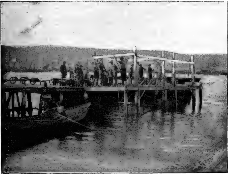
FIG. 11. — Echafaud servant à la préparation de la morue sur le « French-Shore ».
