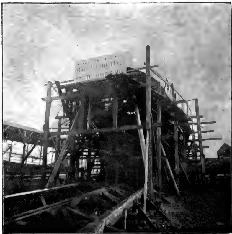
FIG. 70. — Les Œuvres de Mer. Construction du navire-hôpital « Saint-François d'Assises ».
