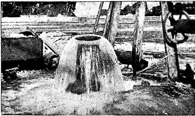
Fig. 350. — Extrémité du tube d'ascension d'un puits artésien.
