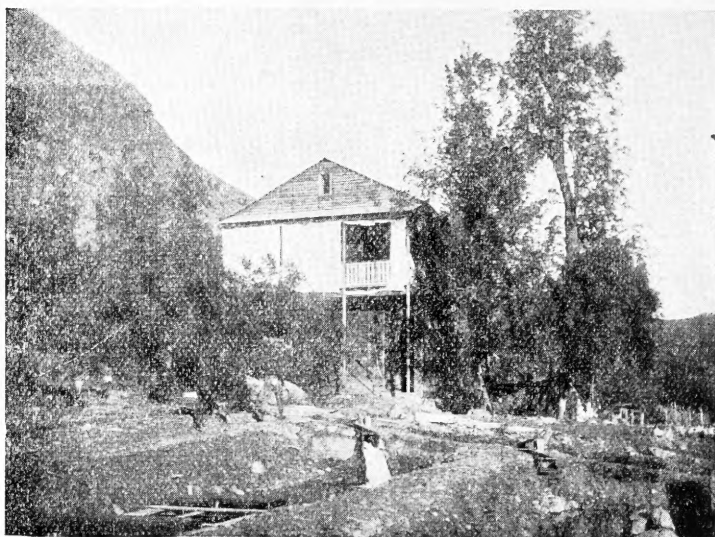
Vista del edificio de Piscicultura en Rio Blanco
