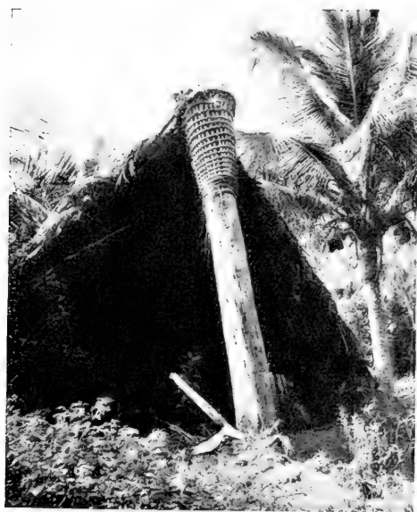
Fig. 18. Case en ruine. Tchambouenne.
