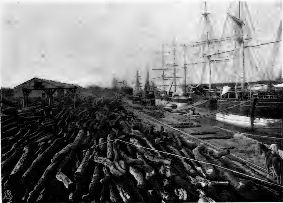
LE PORT DE SANTA-FÉ (Colastiné République Argentine.
