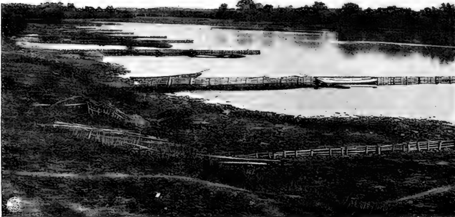
LE FLEUVE TORRENTIEL. — La construction des Épis sur la Loire.
