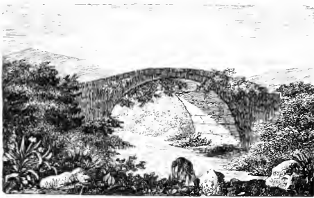
Fig. 192. Brücke von Metaxidi, Messenien.
