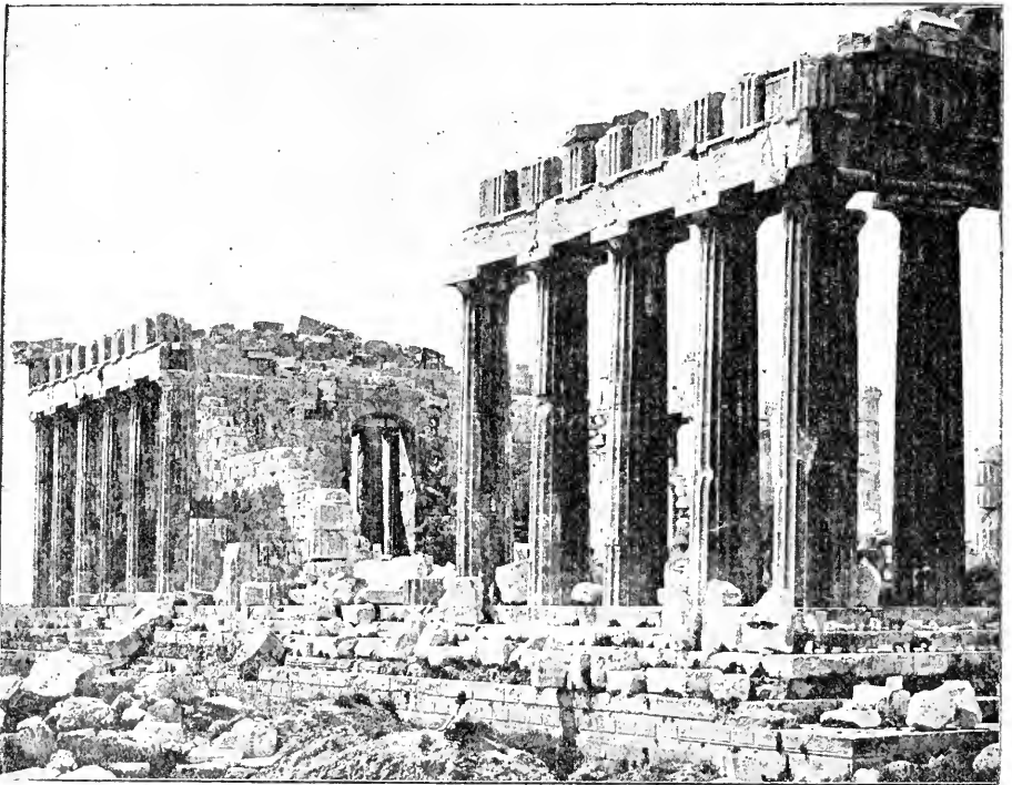
Fig. 120. Parthenon, von Südosten gesehen.
