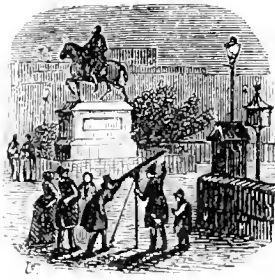
Ferre-plein du Pont-Neuf.
