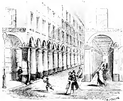
Rue des Colonnes.
