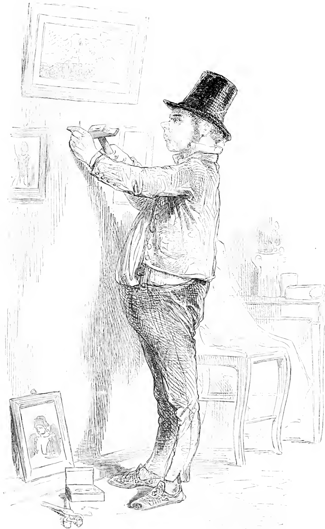
Erection d'un monument.
