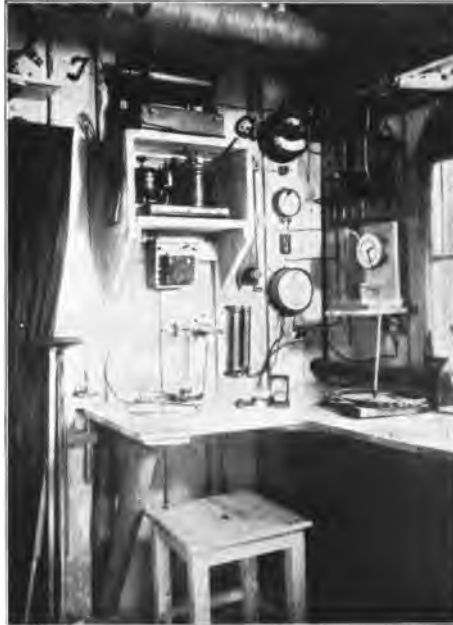
Abb. 128. Induktor und Quecksilberturbine für Braunschen Sender.
