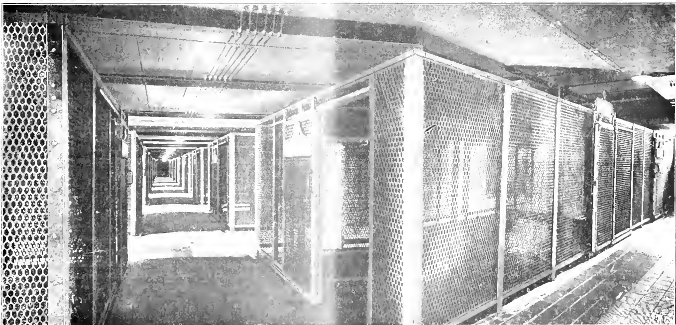
Fig. 120. — Vue intérieure d'une grande installation frigorifique.
