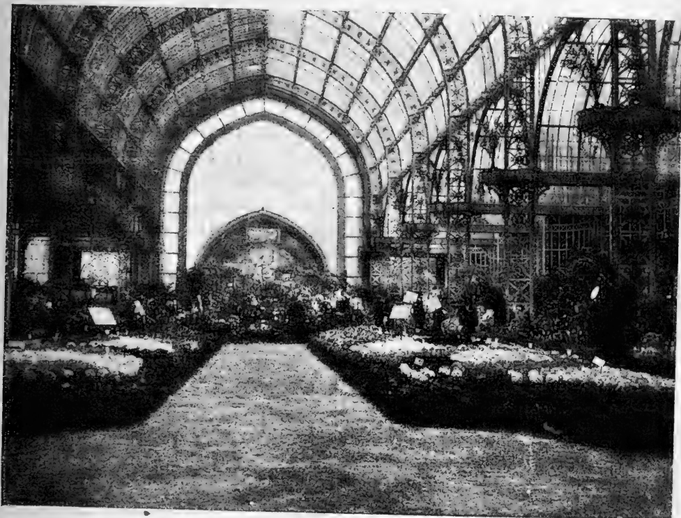
VUE D'ENSEMBLE DE LA SERRE (CÔTÉ DE L'ALMA)
