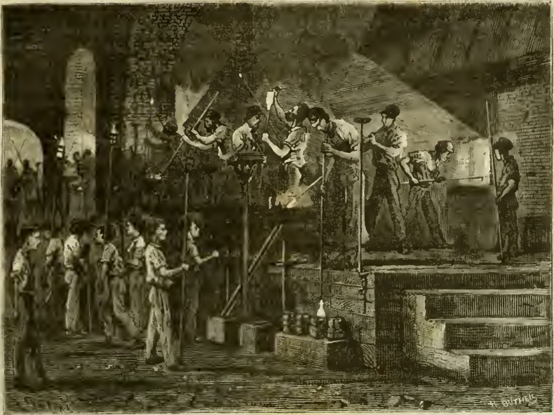
Fig. 41. — Halle pour la fabrication des bouteilles.
