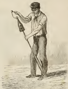
Fig. 39. — Façonnage du goulot de la bouteille.
