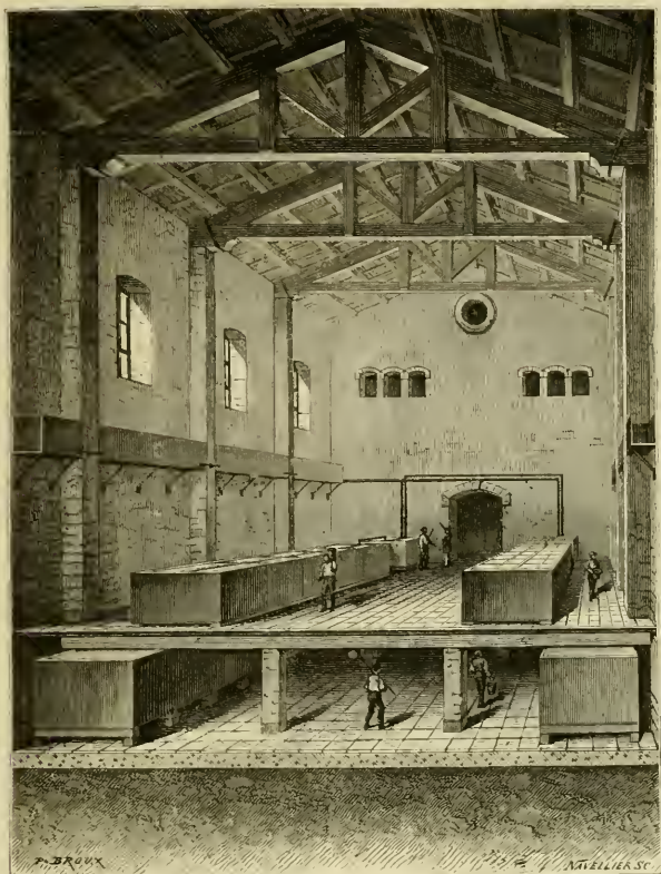
Fig. 278. — Salle des barquieux pour la préparation des lessives de soude, et coupe de la salle des bassines ou récipients des lessives, qui se trouve au-dessous.
