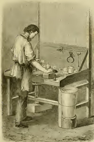
Fig. 106. — Établi de l'ouvrier usant les verres de lunettes.
