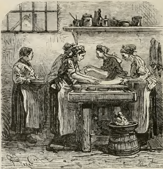
Fig. 52. — Argenture d'une glace par le procédé Drayton.
