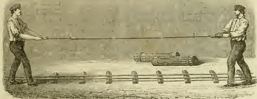
Fig. 44. — Étirage d'un tube et mise en botte des tronçons de tube coupés à la même longueur.
