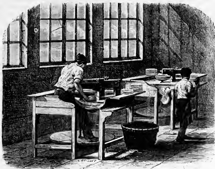
Fig. 262. — Gabarit pour la fabrication des assiettes.
