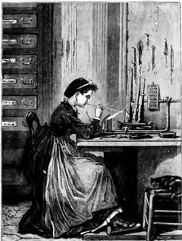
Fig. 97. — Ouvrière parisienne soufflant une fausse perle.
