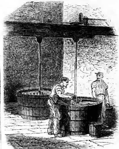
Fig. 266. — Tonneau malaxateur pour le mélange des terres à la manufacture de Sèvres.
