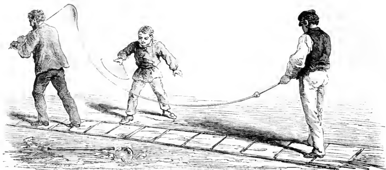
Fig. 45. — Étirage d'un tube. Le gammu refroidit à l'aide d'un éventail les parties du tube qui s'amincissent trop vite.
