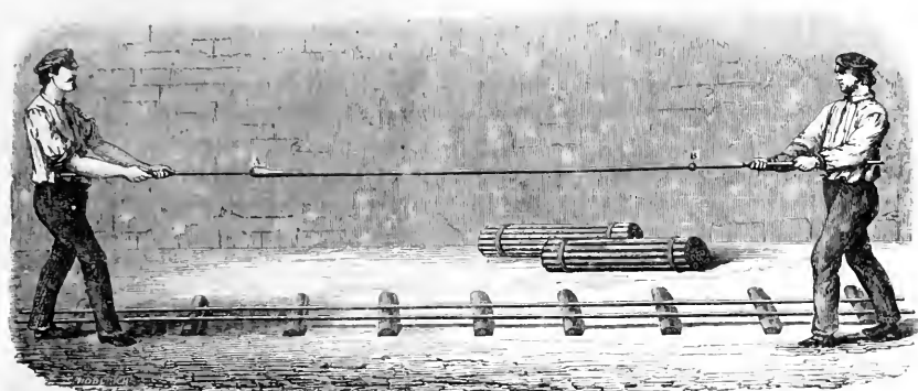
Fig. 44. — Étirage d'un tube et mise en botte des tronçons de tube coupés à la même longueur.
