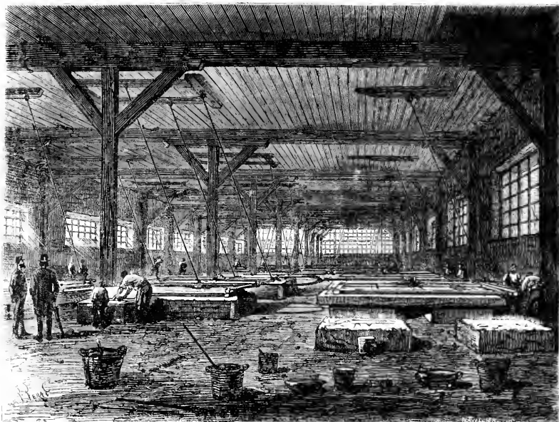
Fig. 51. — Opération du doucissage des glaces
