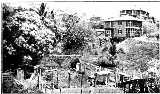
Fig. 58. — A Ancon, zone du canal de Panama. — Maisons avec verandas garnies de toile métallique pour empêcher la pénétration des moustiques. Cliché A.-J. Le Prince et J.-A. Ormslem.
