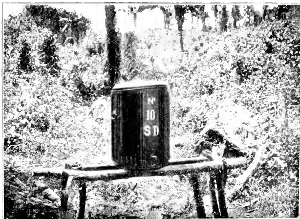
Fig. 93. — Panama. — Appareil à écoulement continu de pétrole, placé sur un ruisseau, en pays accidenté. Excellent système d'épandage du pétrole sur les eaux courantes. (Cliché J.-A. Le Prince et A.-J. Orenstein.)
