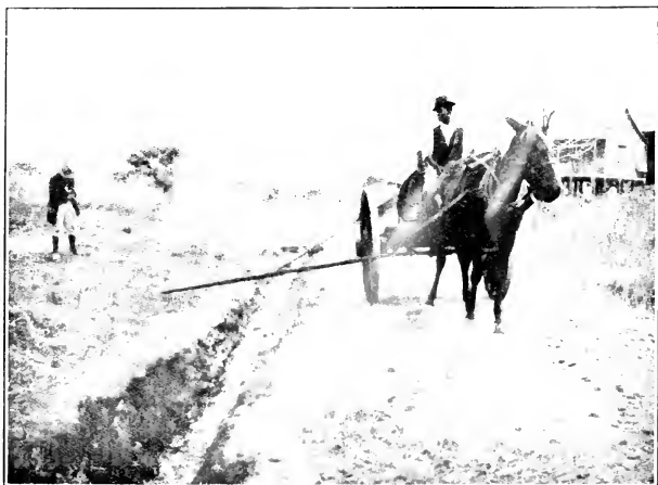
Fig. 94. — Panama. — Epandage du pétrole dans les fosses, le long des routes, à l'aide de charrettes de construction spéciale. — Les Américains n'ont pas regardé aux frais pour lutter contre les moustiques. Ils en ont été remboursés au centuple. (Cliché J.-A. Le Prince et A.-J. Orenstein.)
