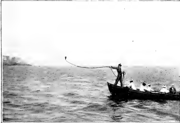
SONDAGES A LA MAIN, PAR PETITES PROFONDEURS
