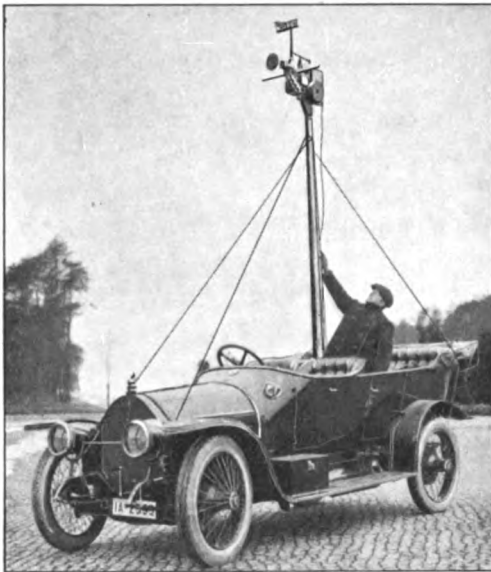
Abb. 8. Eichung der Druckscheibe auf Kraftwagen.
