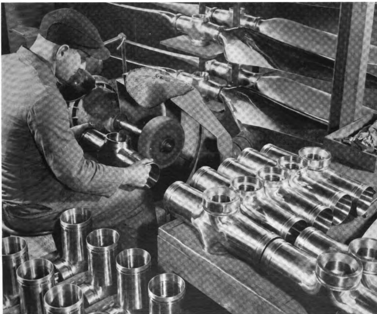
Polieren der Naben von Junkers-Ganzmetall-Luftschrauben
