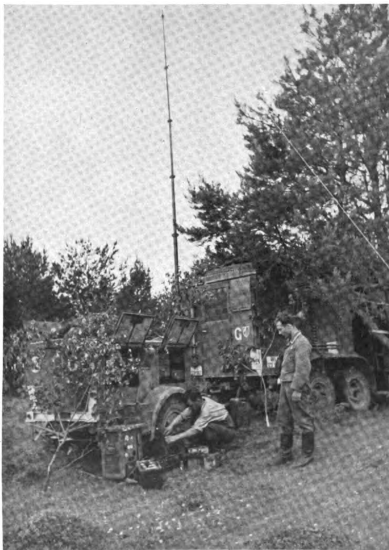
Bei den großen Entfernungen des Ostens ist der Funkverkehr von höchster Bedeutung. Eine Luftnachrichtenabteilung beim Aufbau einer schweren Funkstation
