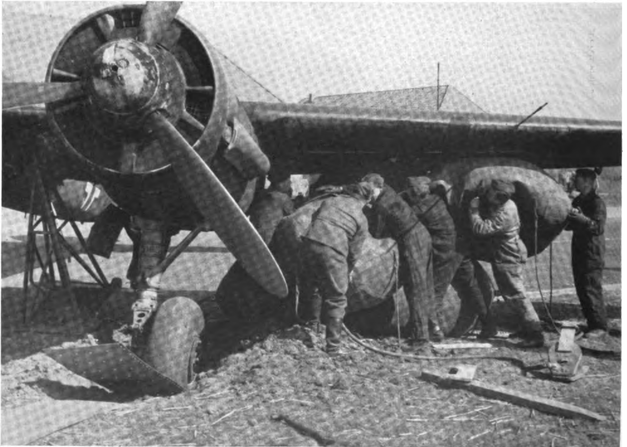
Eine Ju 88, die in dem weichen Boden des Feldflugplatzes eingesunken ist, wird mit Hilfe riesiger Gummisäcke, die mit Blasebälgen aufgepumpt werden, rasch wieder startbereit gemacht
