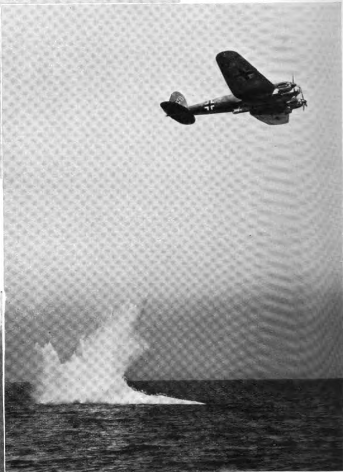
Torpedo-Angriff. Der Flugzeugführer der He 111 hat einen Torpedo ausgelöst, der auf der Meeresoberfläche aufschlägt und dabei eine Wassersäule hochwirft. Die weiße Gischtzunge kennzeichnet den Beginn der Laufbahn des Torpedos, der seine Geschwindigkeit rasch verringert und automatisch die vorher eingestellte Wassertiefe aufsucht
