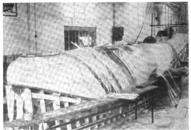
Abb. 5 und 6. Schalenbauweise in Holz nach Zappata
