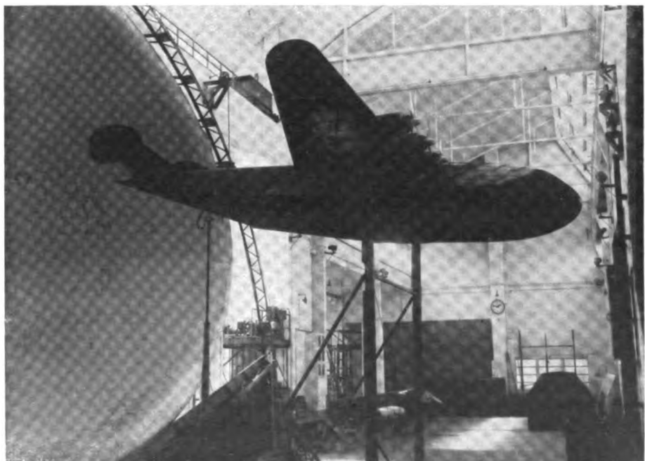
Abb. 5. Modell eines sechsmotorigen Flugbootes „SE 200“. Modell 1 : 4
