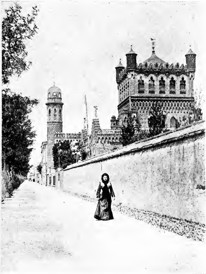
ALCALÁ DE HENARES. PASEO DE LA ESTACIÓN.
