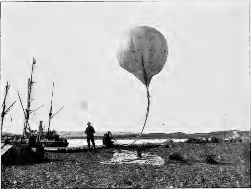
Füllung des Ballons aus den Gasflaschen.
