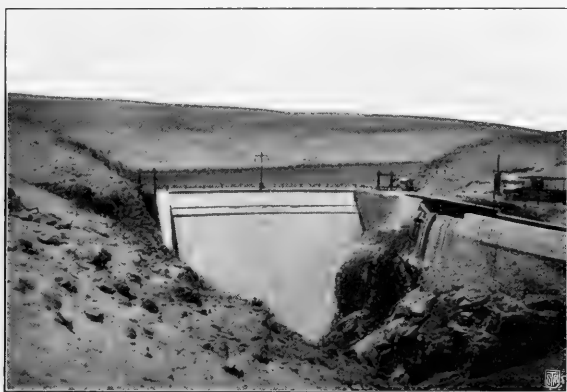
Abb. 14. Sperrmauer im Rio Loa-Tal für das Elektrizitätswerk der Slomanoffizinen in der Toco-Pampa.
