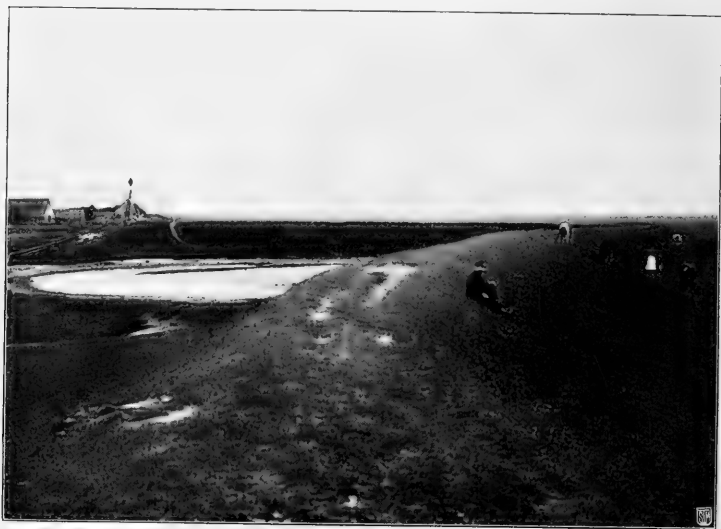
Abbild. 7. Der Seedeich zur Neuwerk mit steiler Innen- und flacher Außenböschung.
