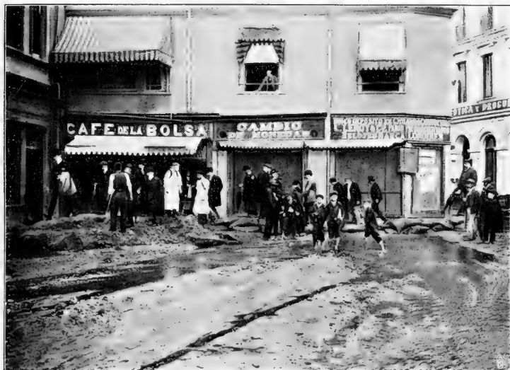
Abb. 8. Straße in Valparaiso nach starken Regengüssen.
