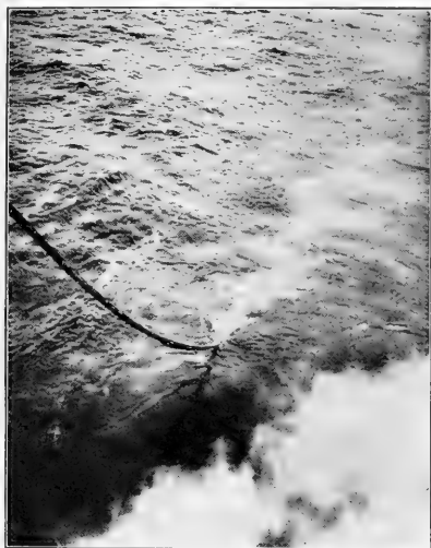
Abb. 27. Spulenstück bei der Verlegung.
