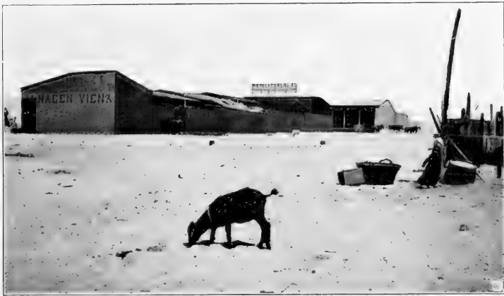
Abb. 25. Straße in Mejillones.
