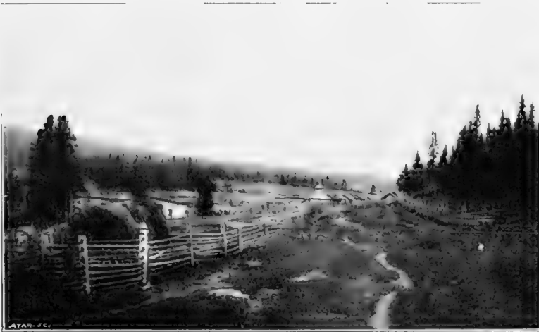
Fig. 12. — Le village de Kyria, vue prise du chemin qui conduit aux anciens placers.
