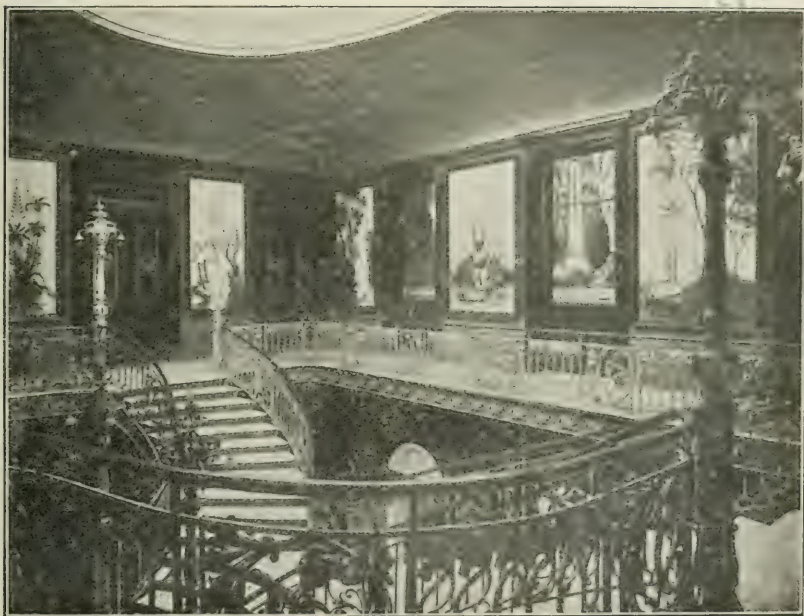
Instituto Geológico.—Vestíbulo y escalera
