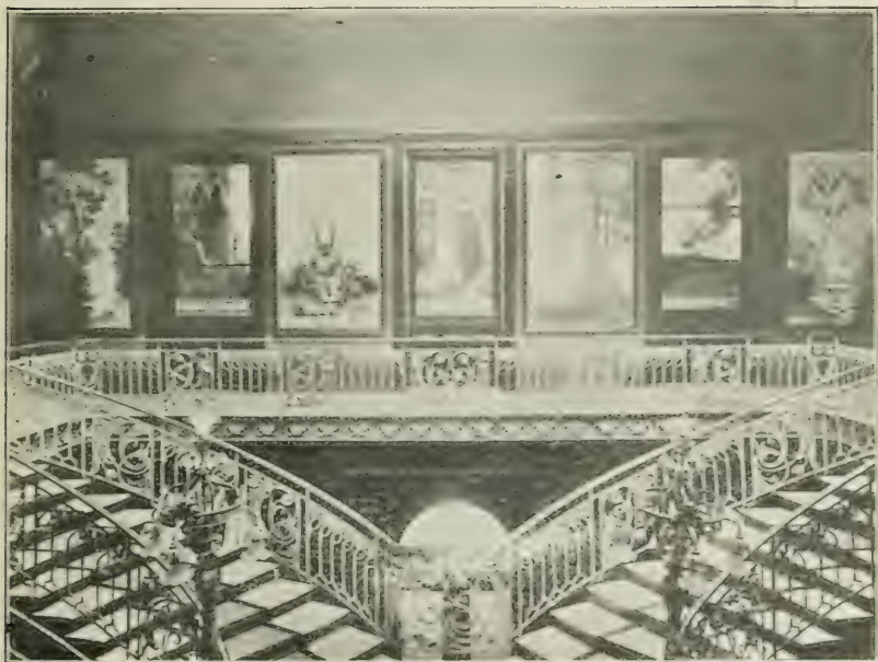
Instituto Geológico.—Vestíbulo y escalera
