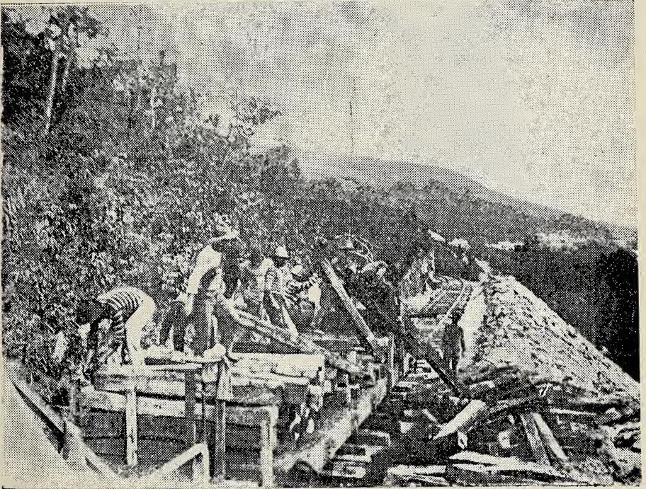
E. F. GOYAZ, MINAS — Descarga de dormentes para o avançamento da linha, na serra da Bocaina
