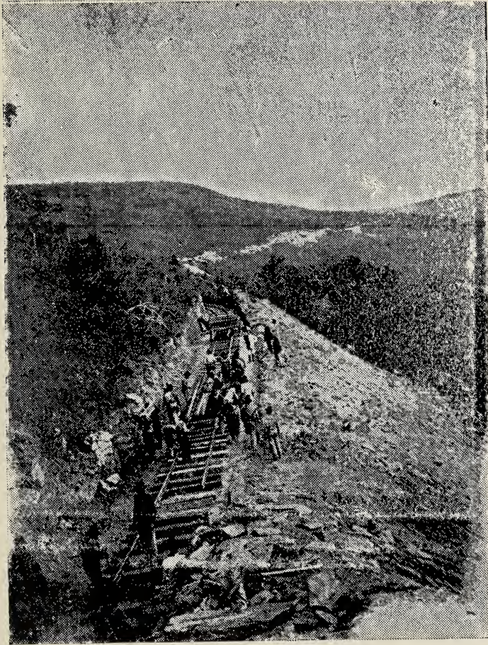
E. F. GOYAZ, MINAS — Assentamento de trilhos na serra da Bocaina, visinhanças do rio Paranahyba
