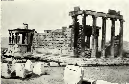
2. Ruine des Erechtheion in Athen.
