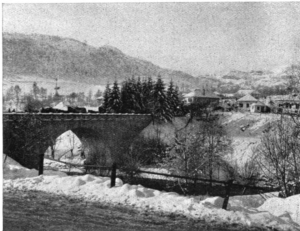
Abb. 10. Brücke über die Dambovitza bei Podul Dambovitii . (1. Div.-Stabsquartier in Rumänien).
