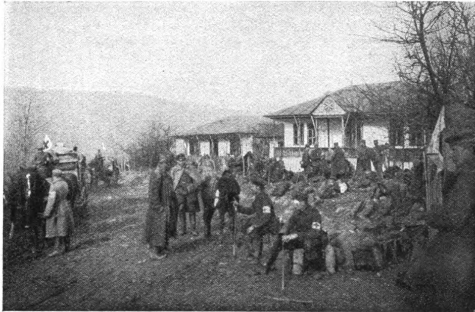
Abb. 47. Verbandplatz und Krankentransportwagen der Sanitäts-Kompagnie in Petrisorul. Phot. Kuntel.
