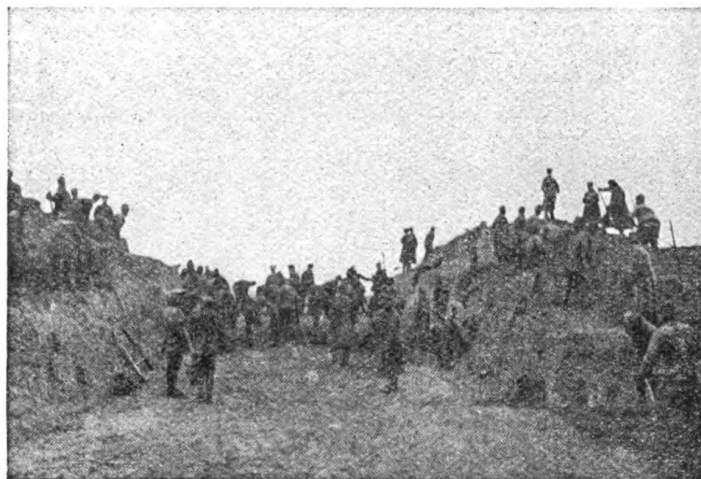
Abb. 94. Bau eines Zufahrtsweges zur Brücke. Phot. Pfäffle.
