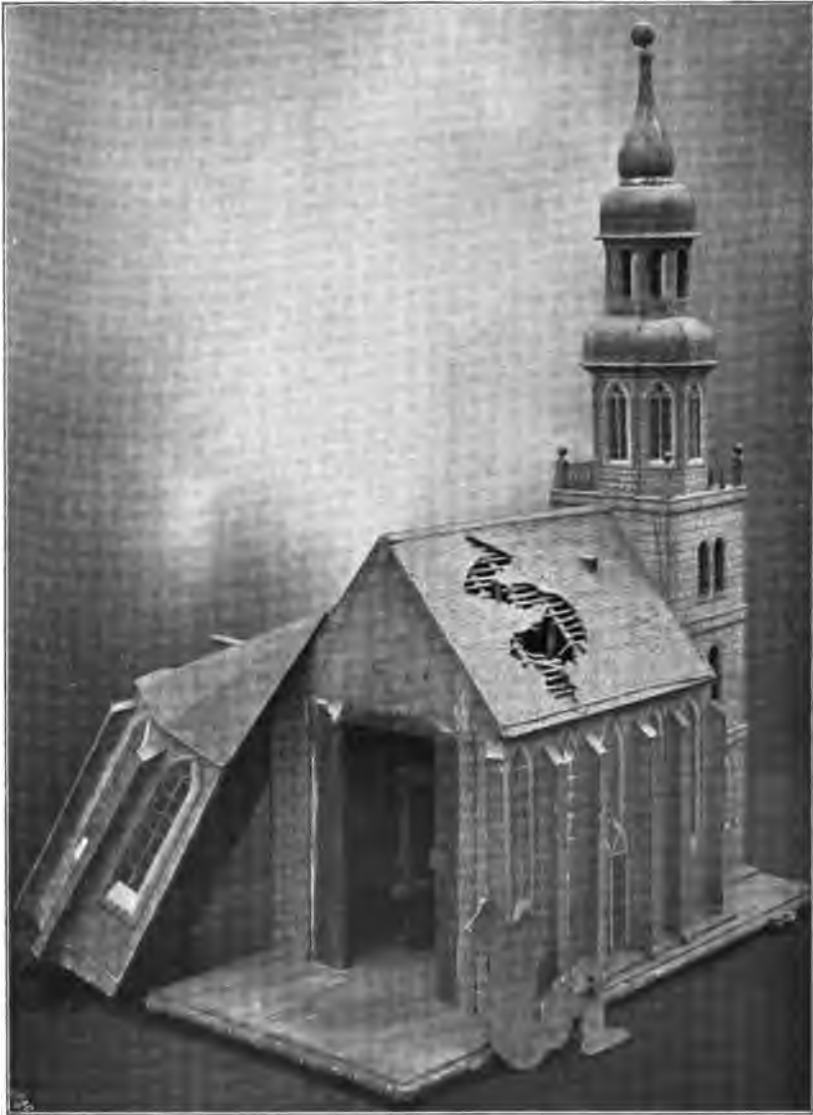
14. Modell einer Kirche zur Veranschaulichung des Blitzeinschlages.
