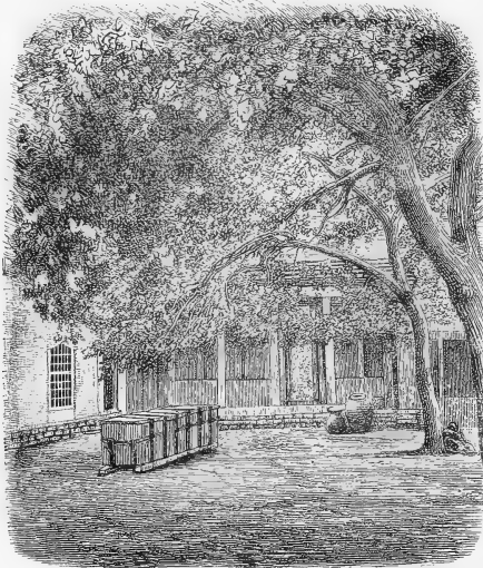
Hofraum; im Hintergrunde die Galerie.
