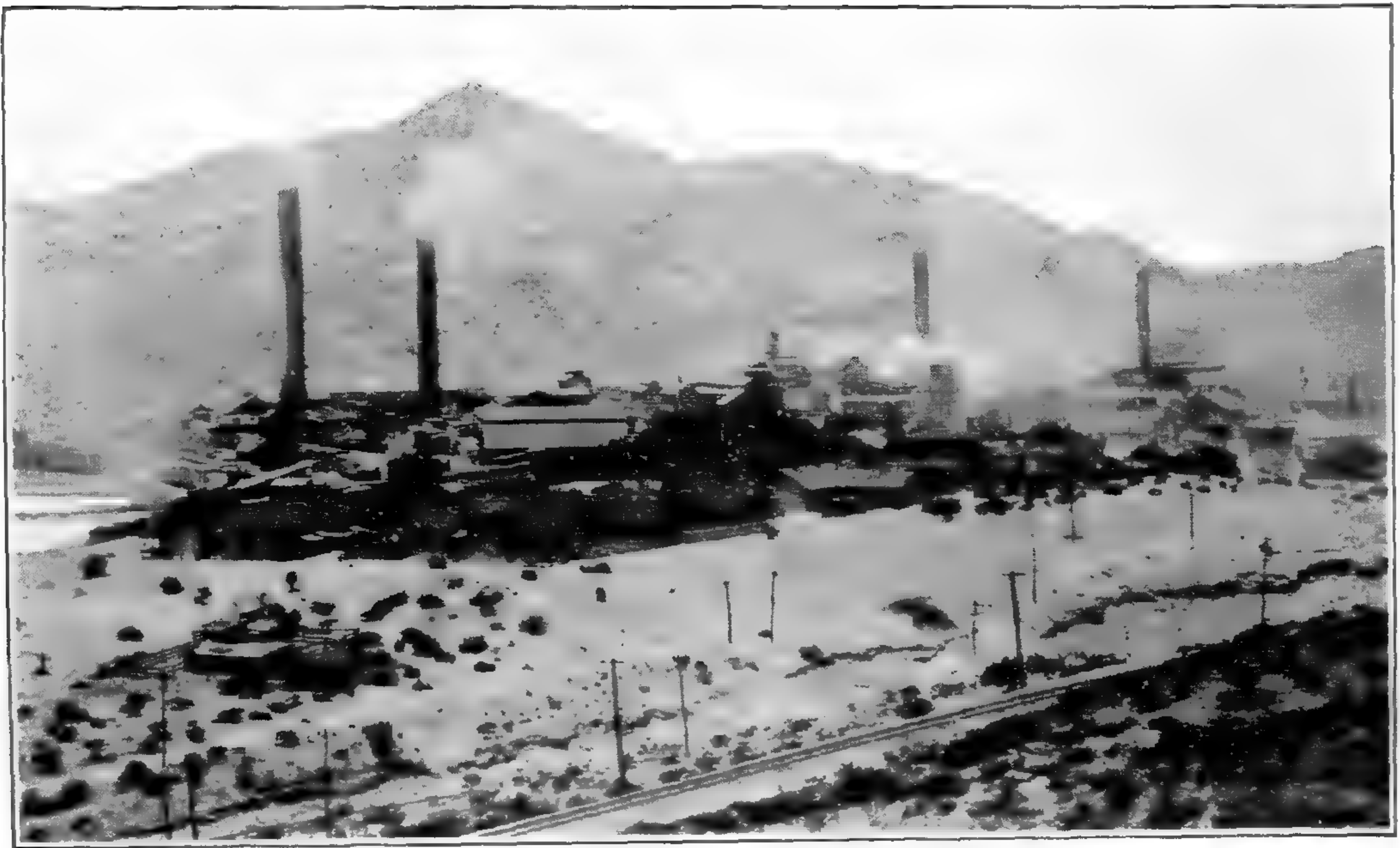
A. SMELTER AT EL PASO, TEX.
