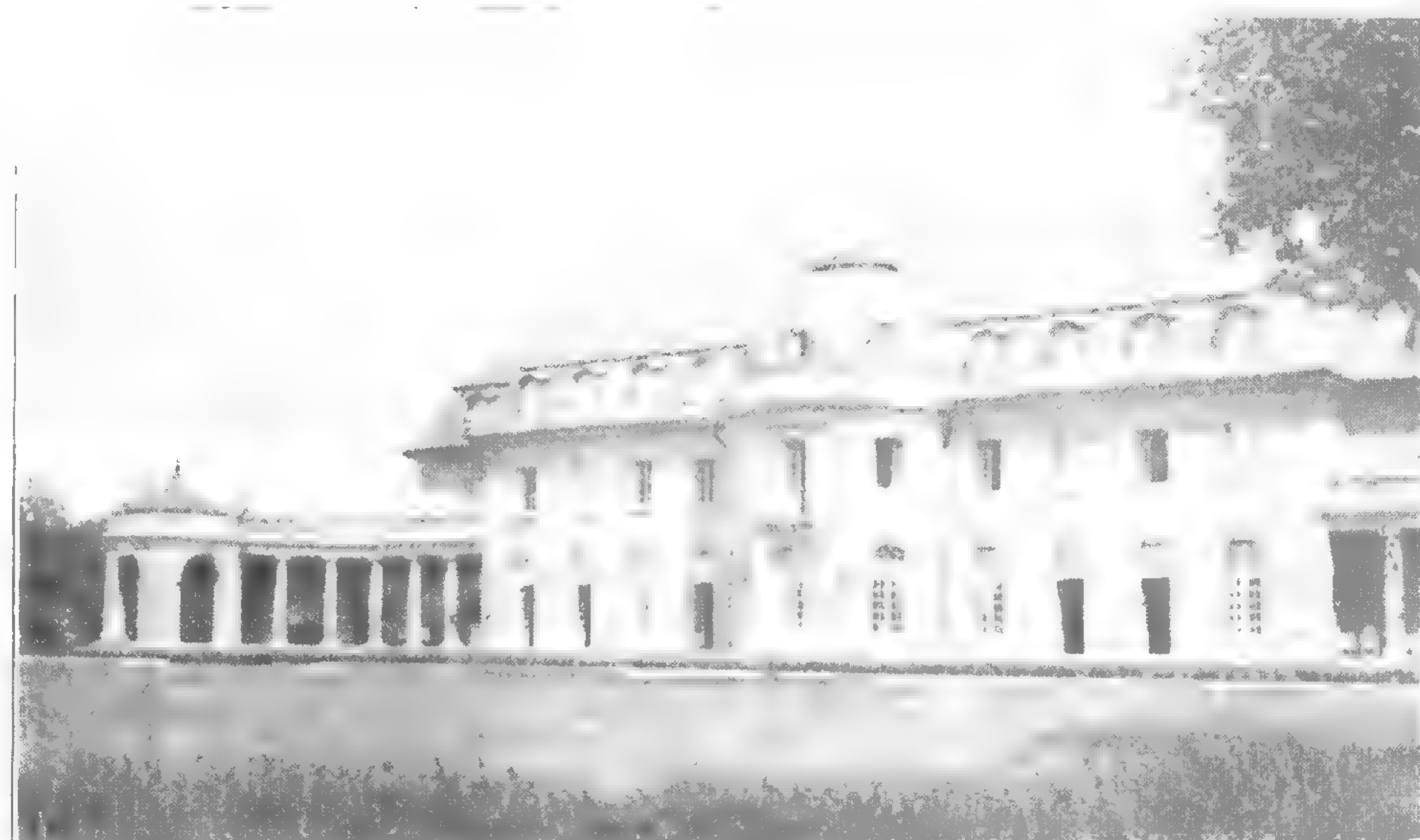
Abb. 5. Gesamtansicht des neuen Schlosses.
