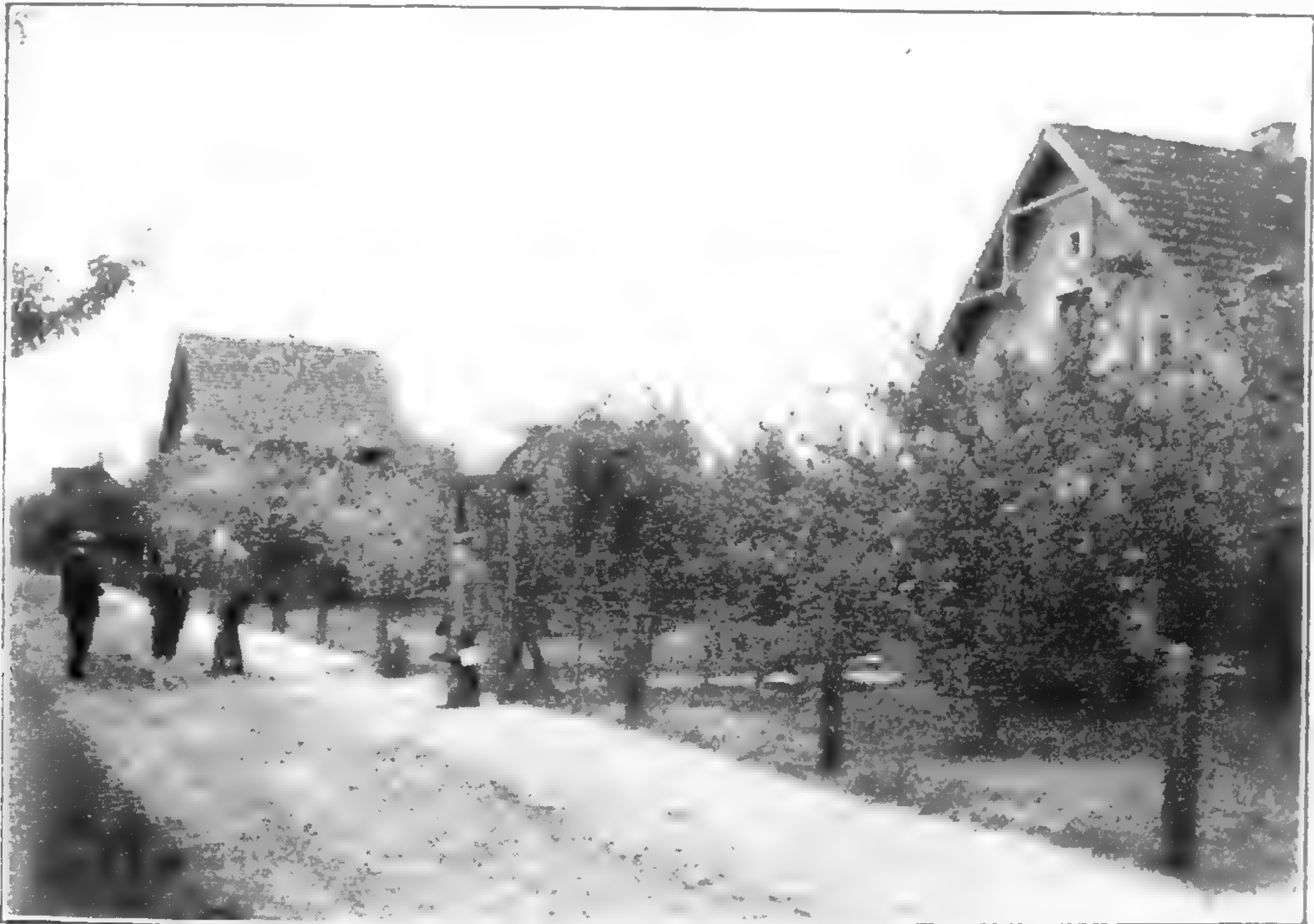
Abb. 65. Dorfstrasse und Heimstättenanlage in der Obstbaukolonie Eden bei Oranienburg.
