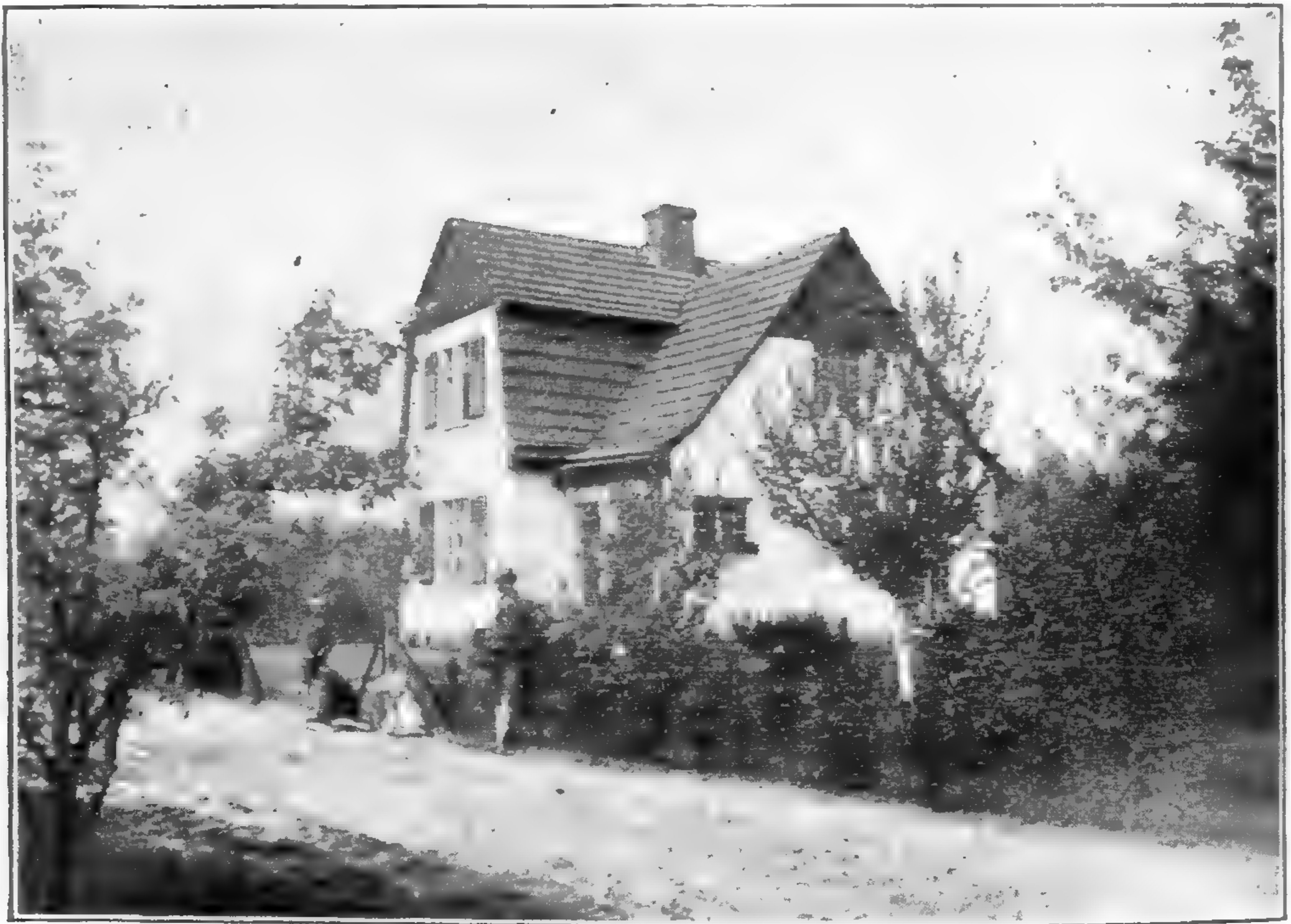
Abb. 62. Ansicht eines kleineren Wohnhauses in der Obstbaukolonie Eden bei Oranienburg. Massiv mit Isolier-Mauerwerk. Es enthält drei Zimmer, Diele, Küche, Waschküche und Keller. Baukosten im Jahre 1910: 5500 Mark.
