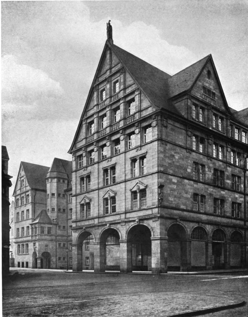
STADTBAUINSPEKTOR KGL. BAURAT BOLTE, CÖLN a. Rh. Das neue Stadthaus an der Gürzenichstraße zu Cöln a. Rh.
