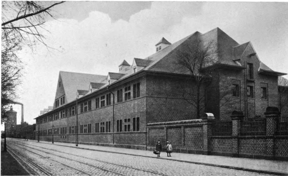
STADTBAUINSPEKTOR KLEWITZ, CÖLN a. Rh. Der Großviehstall des Städtischen Schlacht- und Viehhofs an der Liebigstraße zu Cöln a. Rh.
