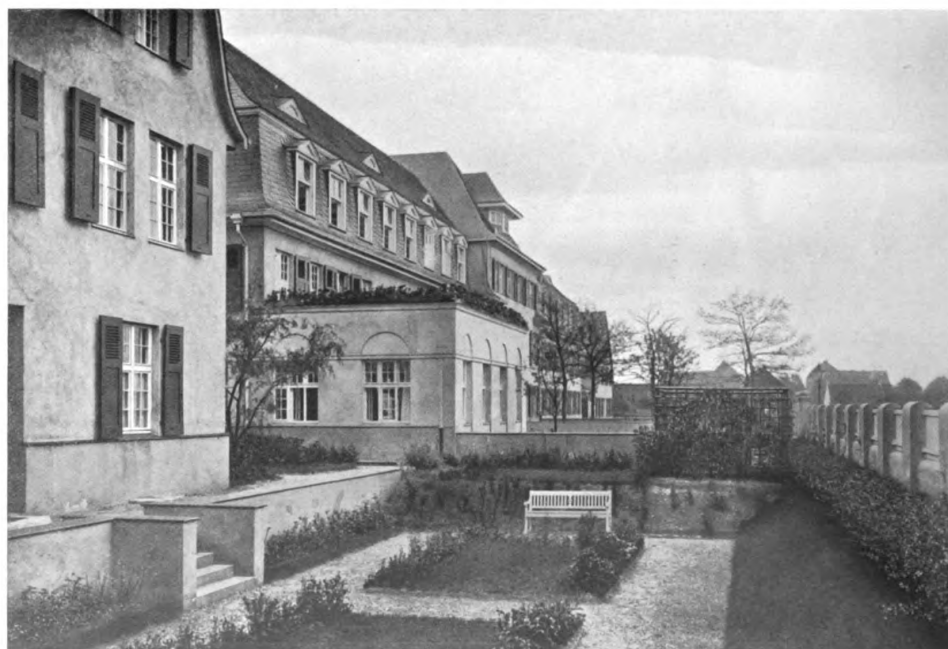
STADTBAUINSPEKTOR KGL. BAURAT KLEEFISCH, CÖLN a. Rh. Von den Gebäuden des Krüppelheims „Stiftung Dr. Dormagen“ zu Cöln-Merheim Vorgärten am Lachemer Weg
