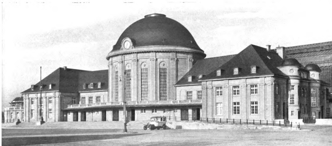
Der neue Bahnhof zu Cöln-Deutz
