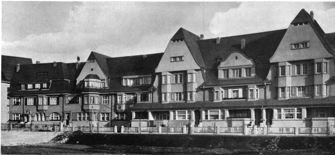
TONI RODENKIRCHEN, MITARBEITER HEINZ FEILL, CÖLN a. Rh. Von der Wohnhausgruppe am Botanischen Garten (vgl. die schraffierte Baugruppe des Bebauungsplanes)
