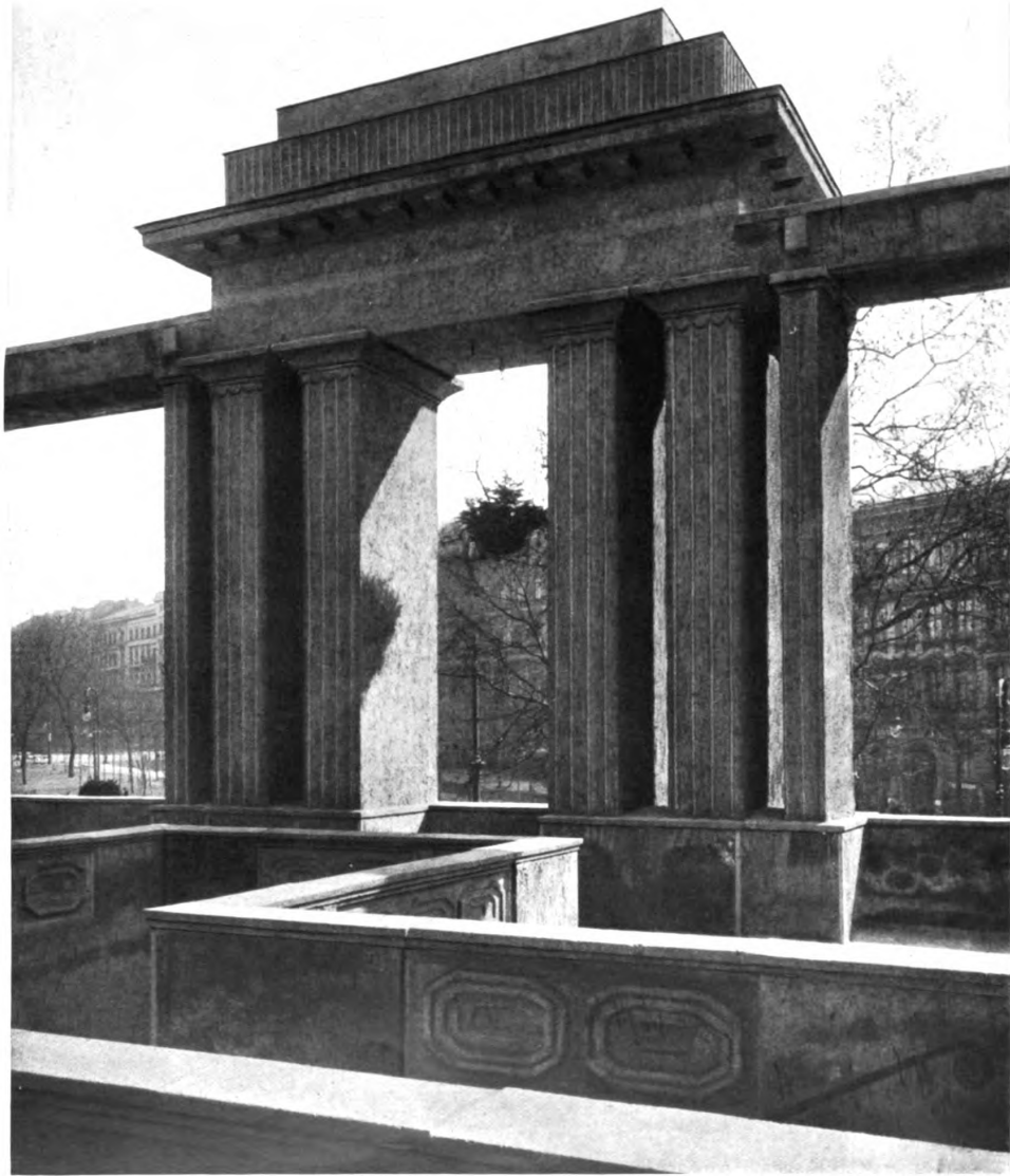
OTTO SALVISBERG, BERLIN Terrassenabschluß am Gebäude der Brauerei Pfefferberg zu Berlin, Schönhauser Allee
