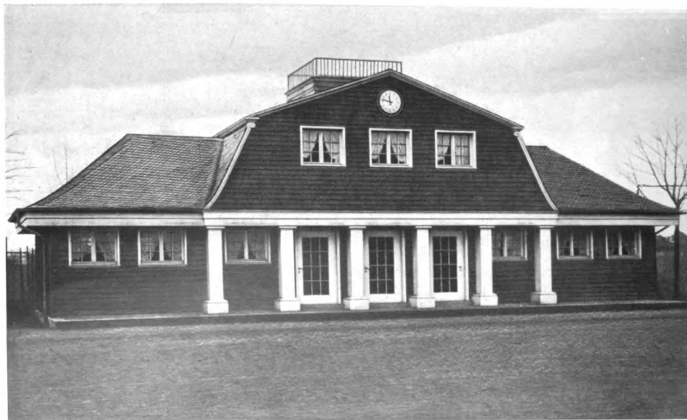
PAUL POTT (B. D. A. u. D. W. B.), CÖLN a. Rh. Oben: Das Haus Zünser zu Cöln-Lindenthal, graue Putzflächen, dunkelbraunes Holzwerk, weiße Fensterrahmen und Betonsäulen. — Unten: Das Tennisklubhaus zu Rodenkirchen a. Rh. bei Cöln, dunkelgrüne Holzschindeln, weißes Holzwerk, Schieferdach
