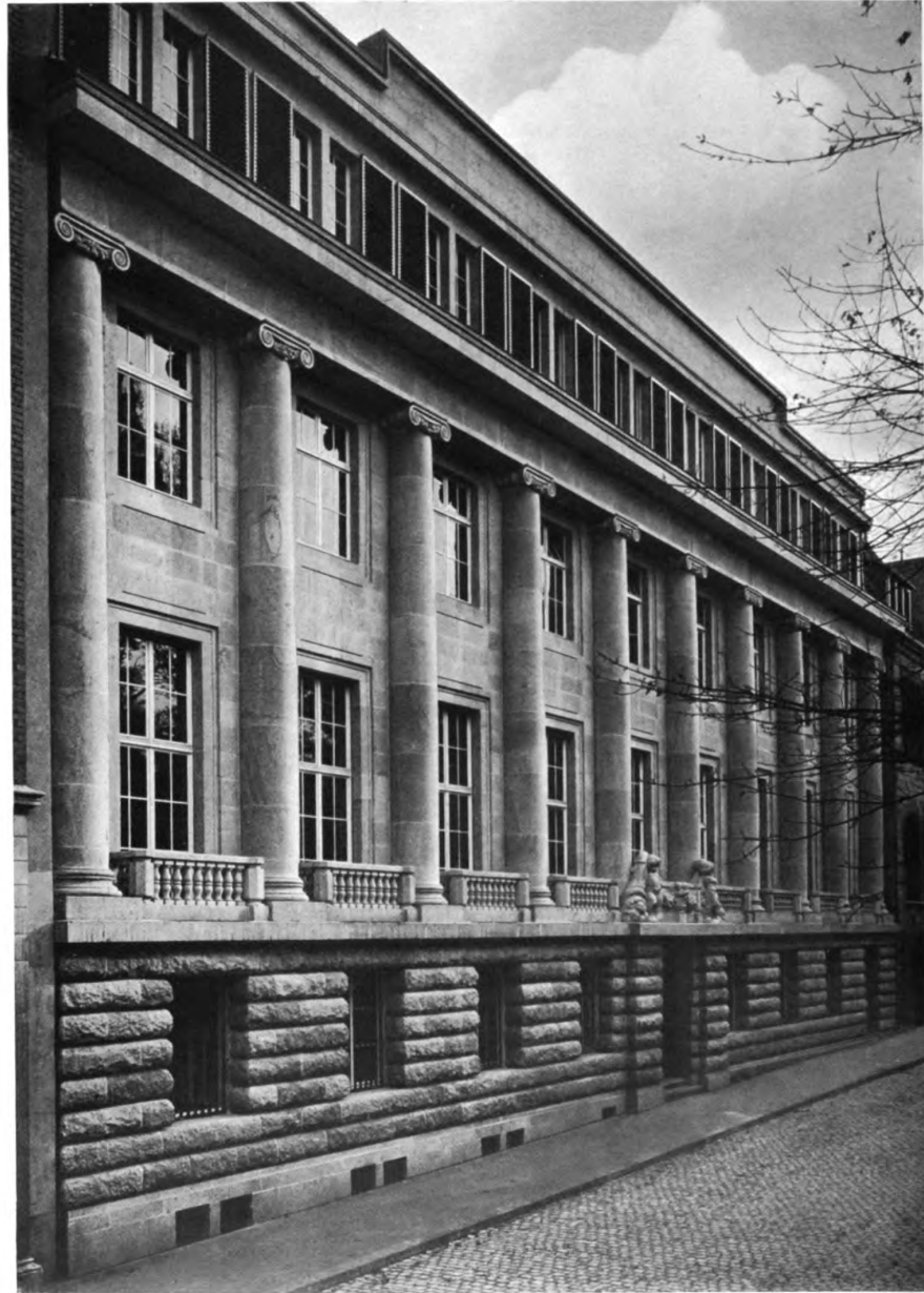
HERMANN PFLAUME (B. D. A. u. D. W. B.), CÖLN a. Rh. Der Erweiterungsbau der Cölner Lebensversicherungs-Gesellschaft „Concordia“ in der Eintrachtstraße zu Cöln a. Rh. — Material: Westerwälder Tradyt von Carl Ackermann, Steinbruchbesitzer, Cöln. — Bildhauer Erwin Haller, Cöln
