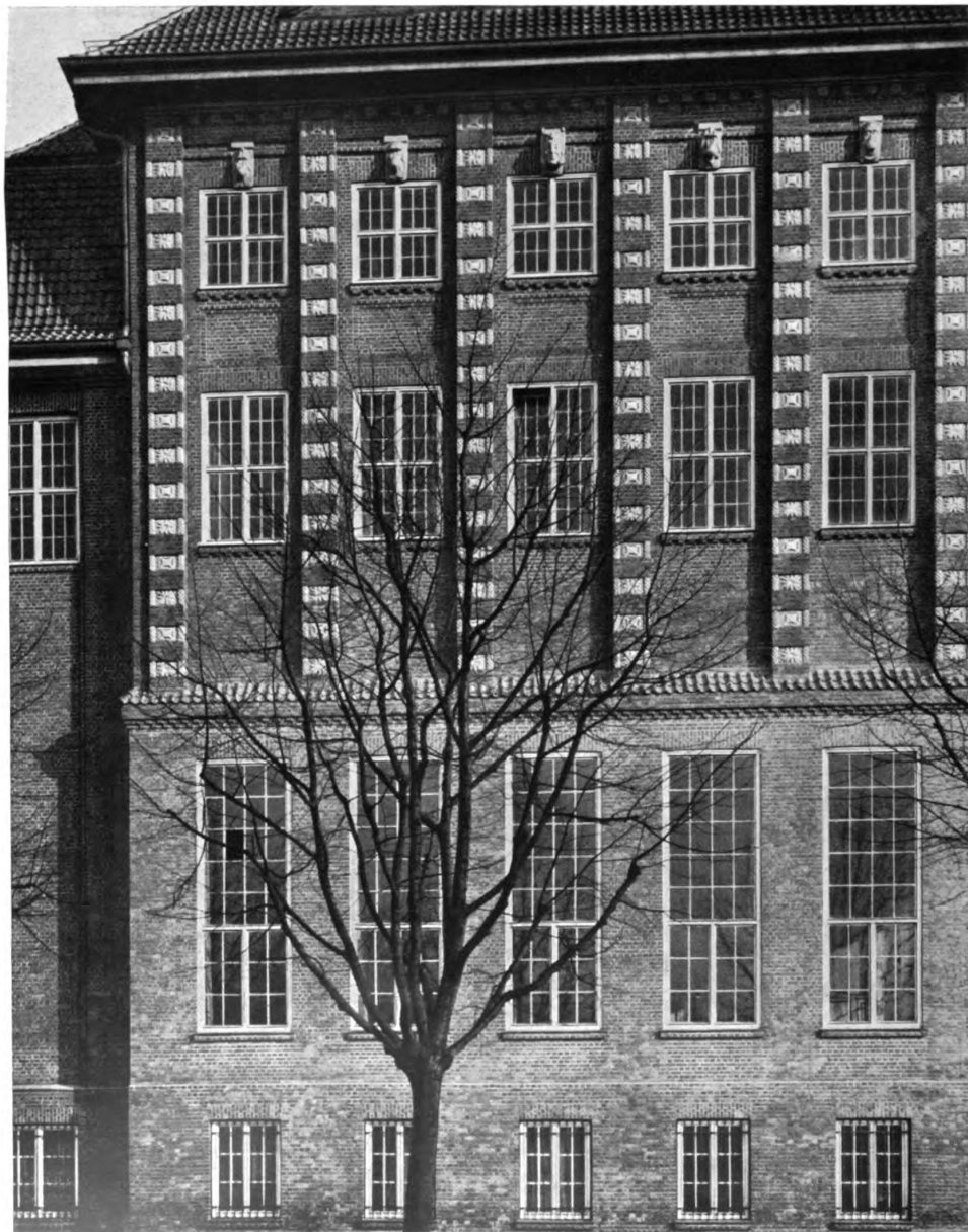
BAUDIREKTOR PROFESSOR FRITZ SCHUMACHER, HAMBURG Die Kunstgewerbeschule zu Hamburg. — Detail der Fassade Baðstein mit Steinzeug-Keramik, ausgeföhrt von A. H. Wessely, Hamburg
