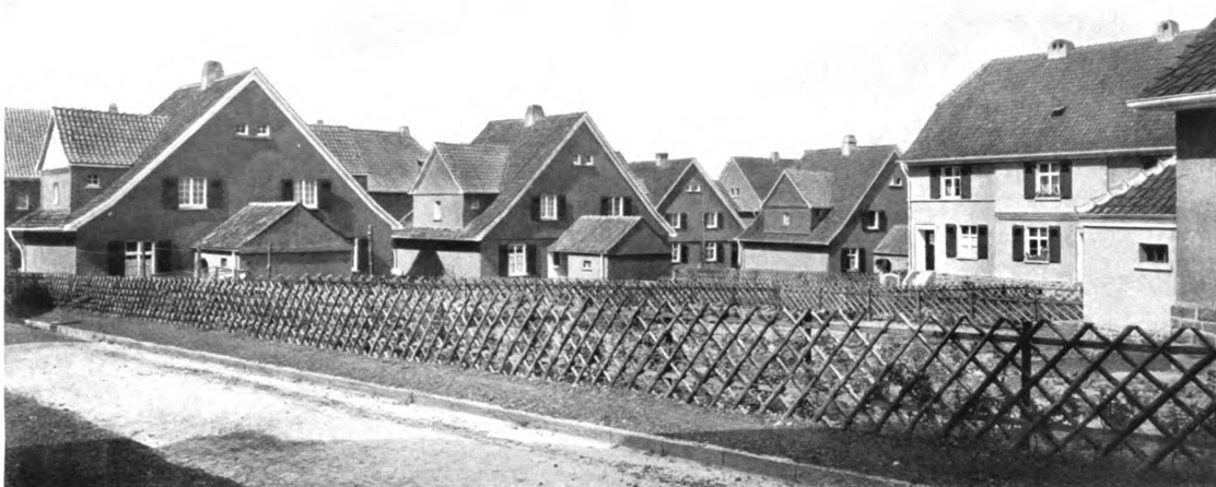
PROFESSOR GEORG METZENDORF, ESSEN-RUHR Die Gartenstadt Hüttenau bei Blankenstein a. Ruhr. — Blick auf die Rückseiten der Häuser
