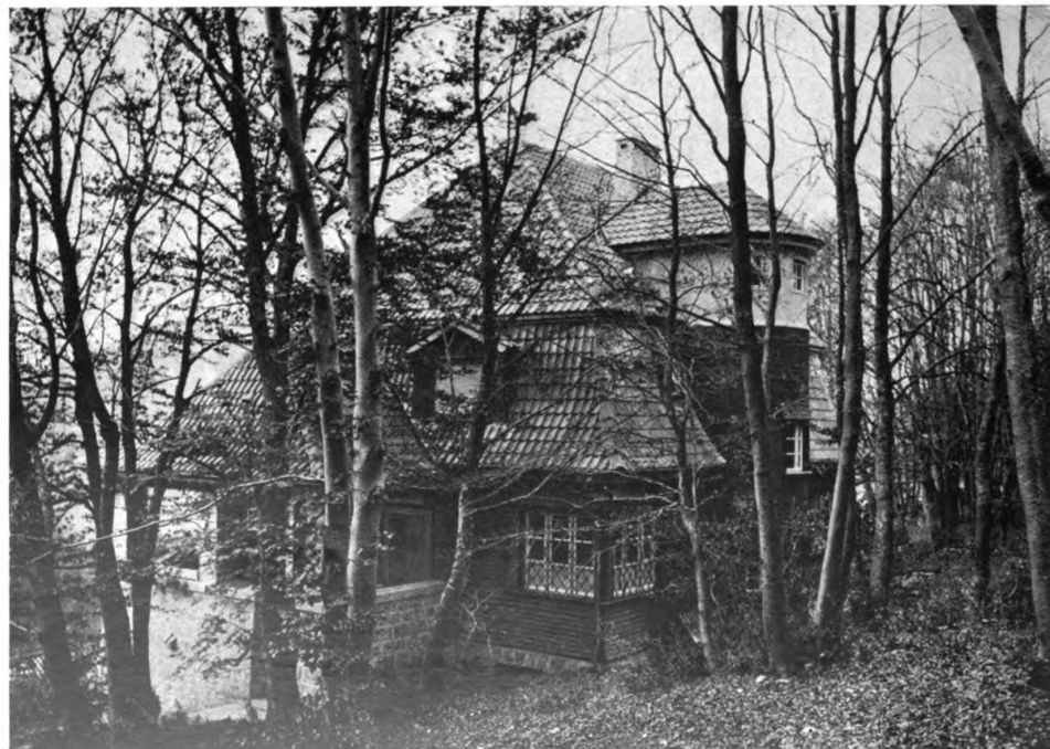
EISENLOHR & PFENNIG, STUTTGART Das Sommerhaus des Fabrikanten Louis Gminder am Traifelberg beim Lichtenstein Oben: Ansicht gegen das Tal. — Unten: Rückansicht
