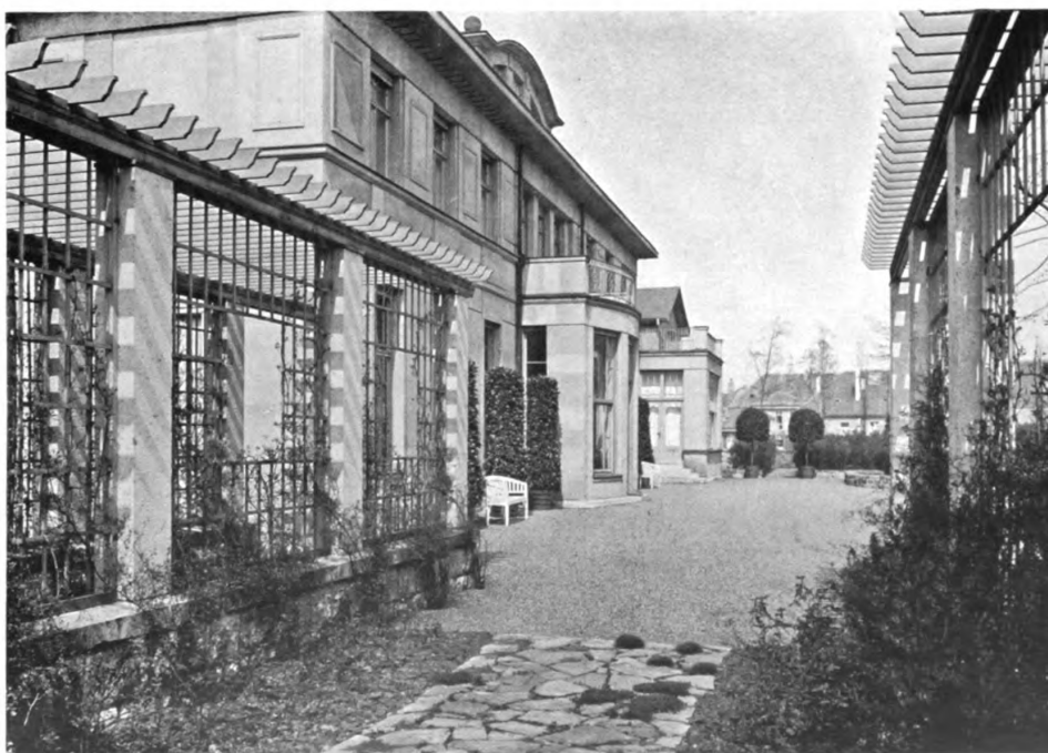
PROFESSOR EDMUND KÖRNER, ESSEN-DARMSTADT Das Haus E. v. Waldhausen zu Essen-Ruhr. — Oben: Blick von der Terrasse nach dem Gartenhaus. Unten: Blick auf die Terrasse hinter dem Wohnhause
