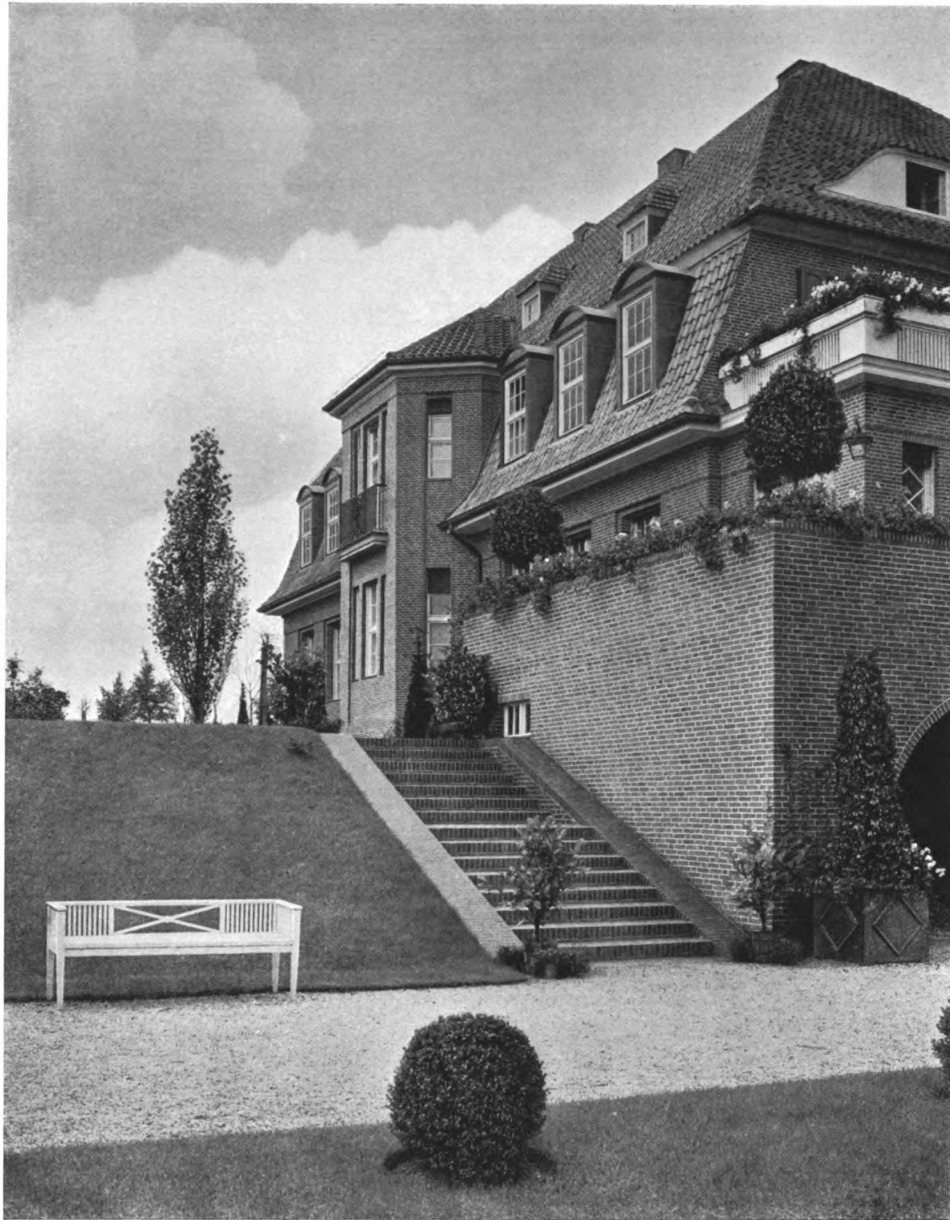
PROFESSOR FRANZ SEECK, BERLIN Das Wohnhaus Rudolf Hauptner in Zehlendorf-West bei Berlin Ansicht des Hauses von der Gartenterrasse
