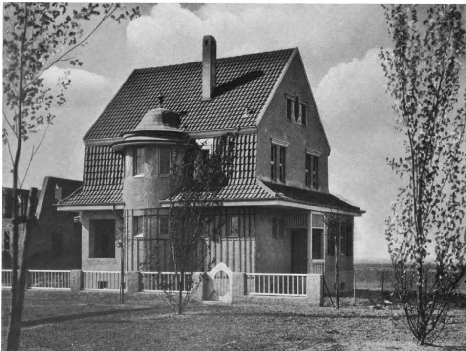
REG.-BAUMEISTER MAX STIRN (D.W.B.), CÖLN a. Rh. Oben: Ein Doppelwohnhaus. — Unten: Ein Einfamilienhaus, beide in der Landhauskolonie Stirth bei Cöln
