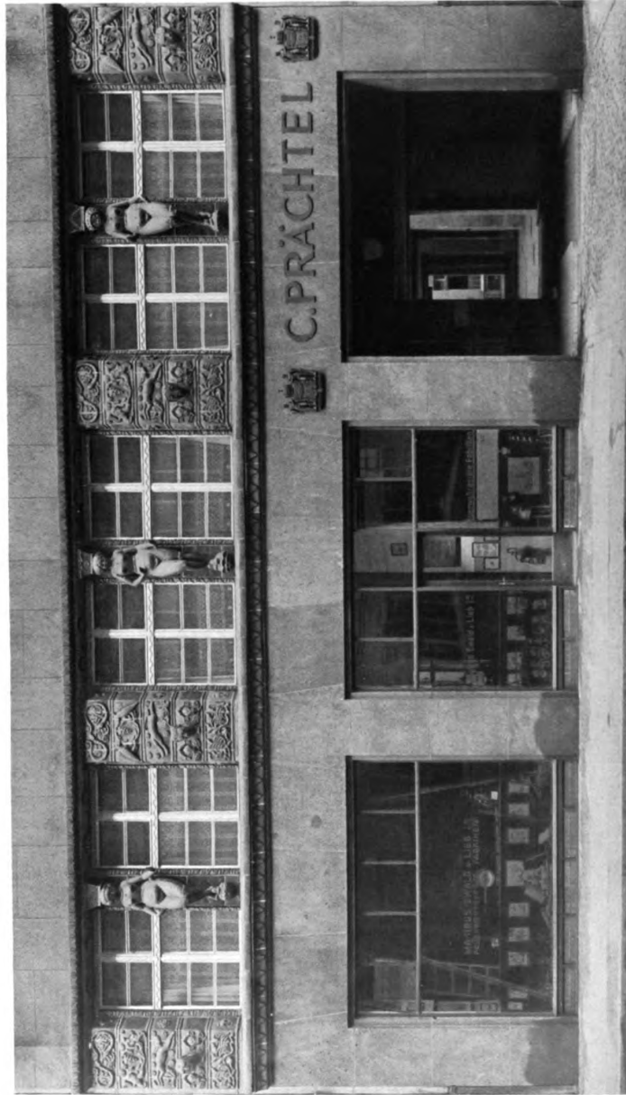
OTTO SALVISBERG, BERLIN Von der Fassade des Geschäftshauses C. Prächtel zu Berlin, Schützenstraße Verkleidung in Muschelkalkplatten und schwarzer Keramik der keramischen Werkstätten Adler, Vellen (Mark) Alle Bildhauerarbeiten von P. R. Henning, Berlin
