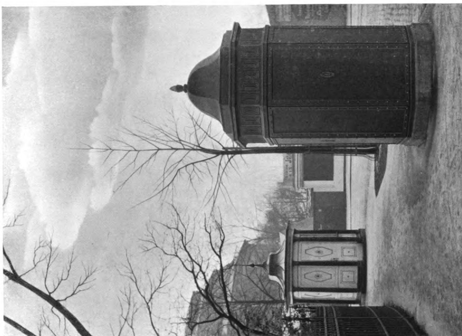
STADTBAUINSPEKTOR KLEWITZ, CÖLN a. Rh. Transformatorenhäuschen Vorwärts G. m. b. H. Bentele & Kleefisch, Cöln a. Rh.
