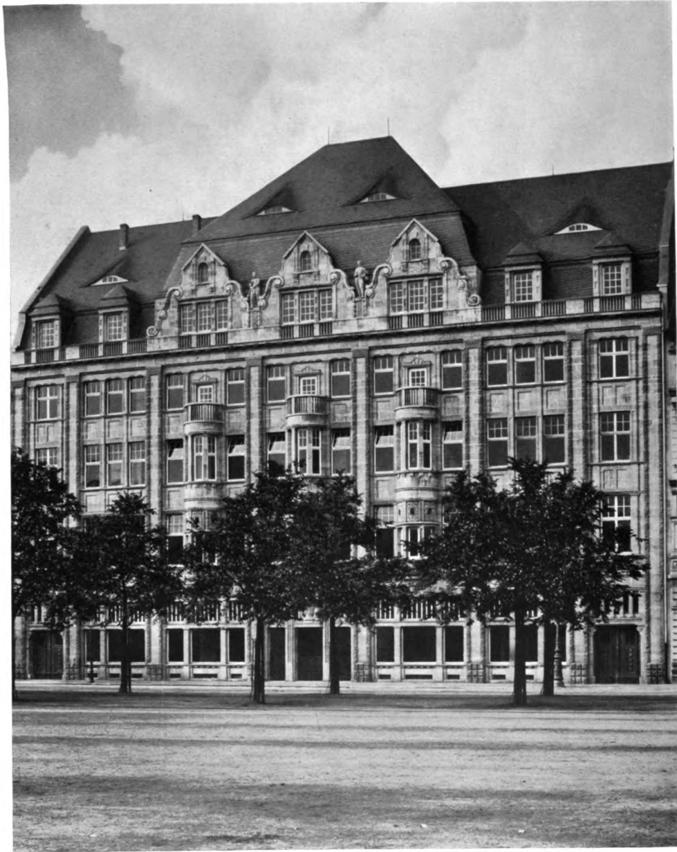
H. MÜLLER-ERKELENZ, CÖLN a. Rh. Das Geschäftshaus der Firma Gebrüder Bing Söhne am Neumarkt zu Cöln a. Rh. Material: Kirdheimer Muschelkalk
