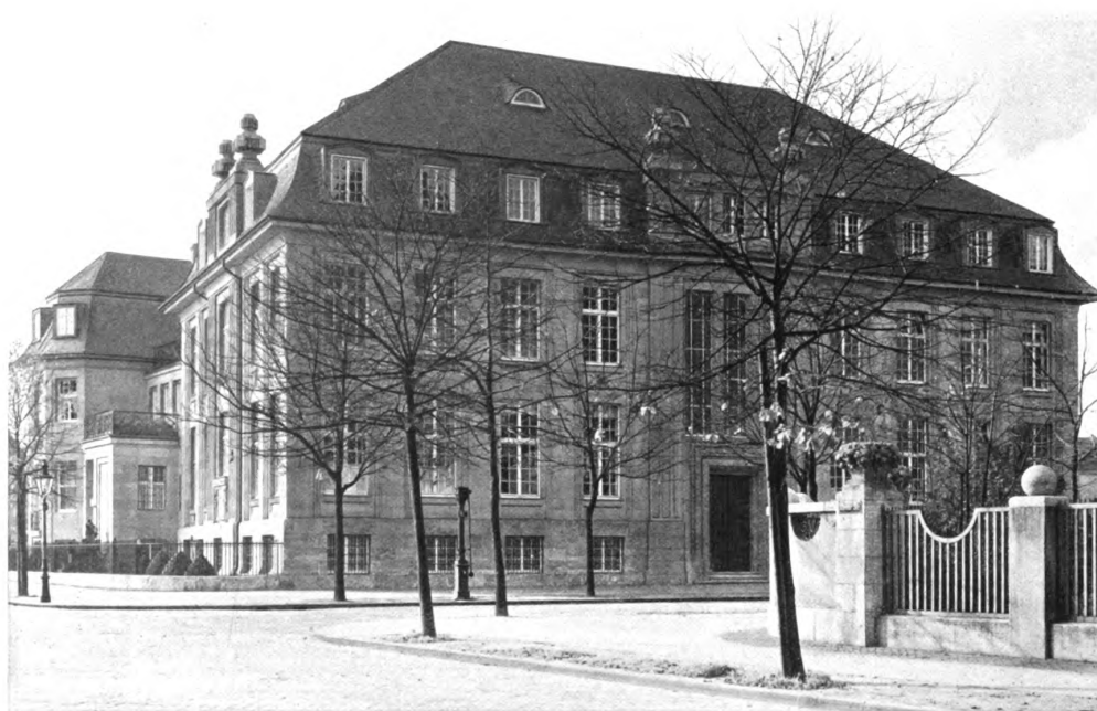
SCHREITERER & BELOW (B. D. A.), CÖLN a. Rh. Das Bureaugebäude und Direktorwohnhaus der „Rhenania“ Versicherungs-Aktien-Gesellschaft zu Cöln a. Rh.
