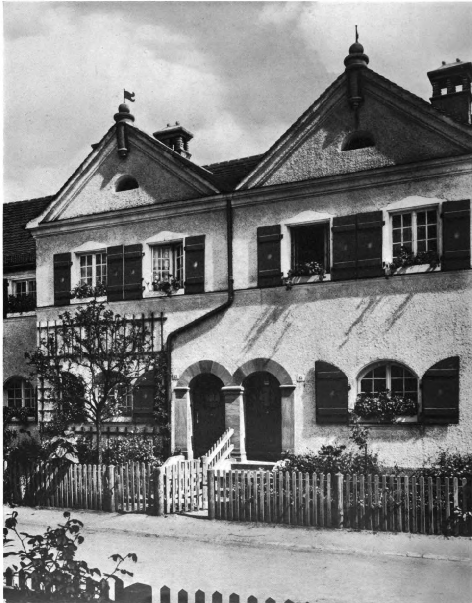
PROFESSOR LUDWIG RUFF, NÜRNBERG Die Gartenvorstadt Werderau bei Nürnberg. — Von der Einfamilienhäusergruppe 4 für Beamte, Meister und Arbeiter
