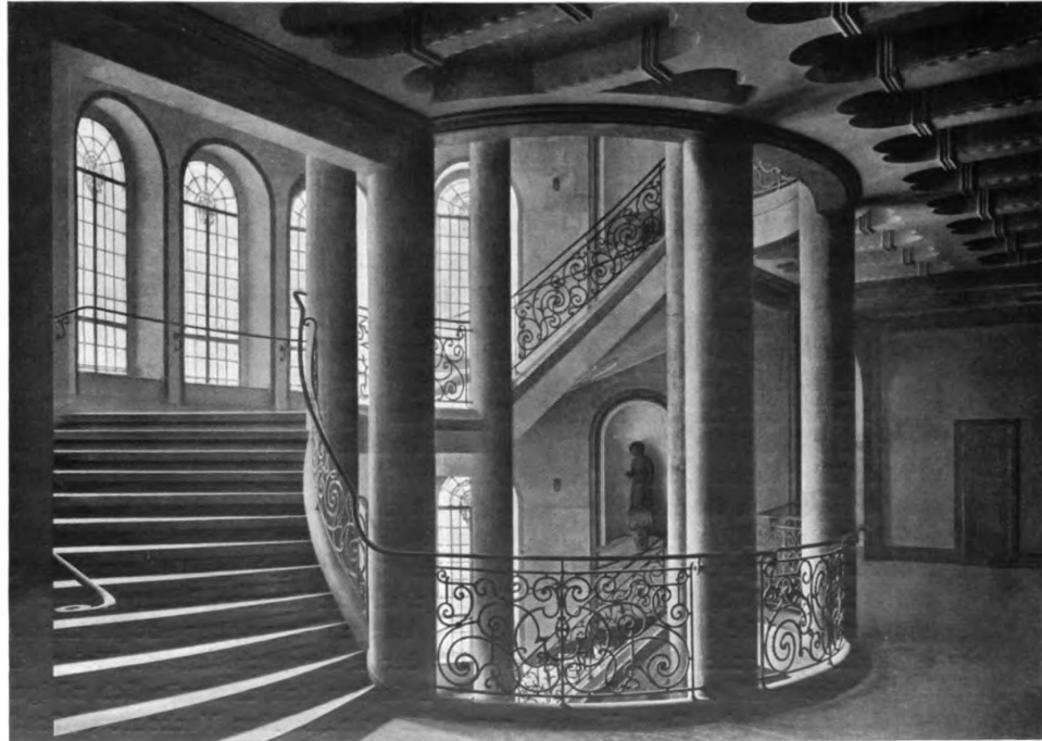
STADTBAUINSPEKTOR KGL. BAURAT BOLTE, CÖLN a. Rh. Das neue Stadthaus zu Cöln a. Rh. — Oben: Sitzungssaal im ersten Obergeschoß Unten: Blick in das Haupttreppenhaus
