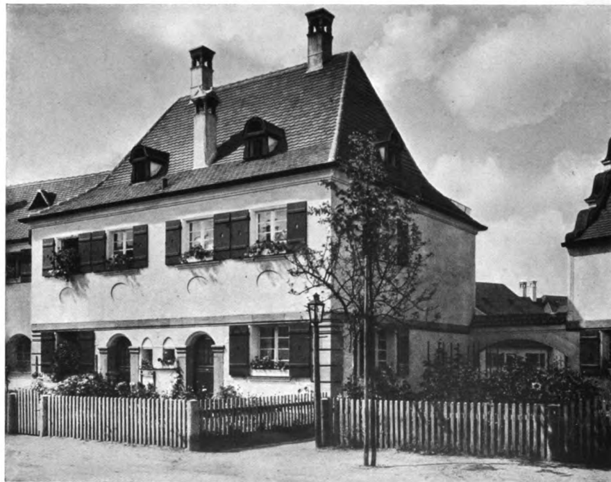
PROFESSOR LUDWIG RUFF, NÜRNBERG Die Gartenvorstadt Werderau bei Nürnberg. — Von der Einfamilienhäusergruppe 8 für Beamte, Meister und Arbeiter
